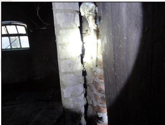
Fig. 2.11, Luchtsponw zichtbaar in gebouw 5 (bron: FF Solutions)
