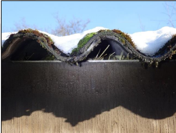
Fig. 2.21, Mogelijk nestmateriaal tussen dakplaten en dakbeschoot in gebouw 8 (bron: FF Solutions)
