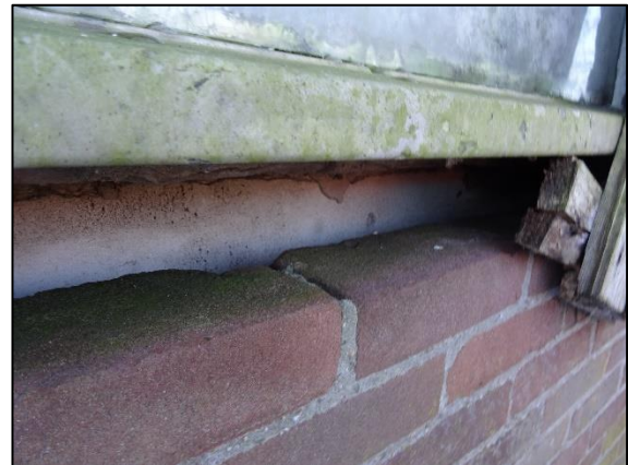
Fig. 2.16, Luchtspouw zichtbaar in gebouw 6 bij kozijn (bron: FF Solutions)
