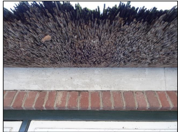
Fig. 2.4, Detailopname van overgang dak op muur van woonboerderij (bron: FF Solutions)
