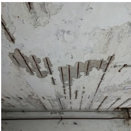
21.1 Schade aan de betonnen begane grond, roestende wapeningsstaven en weinig dekking
