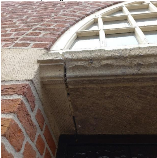
35.1 en 35.2, Natuursteenprofiel is weggesleten en de voegen zijn te hard/ eruit.
