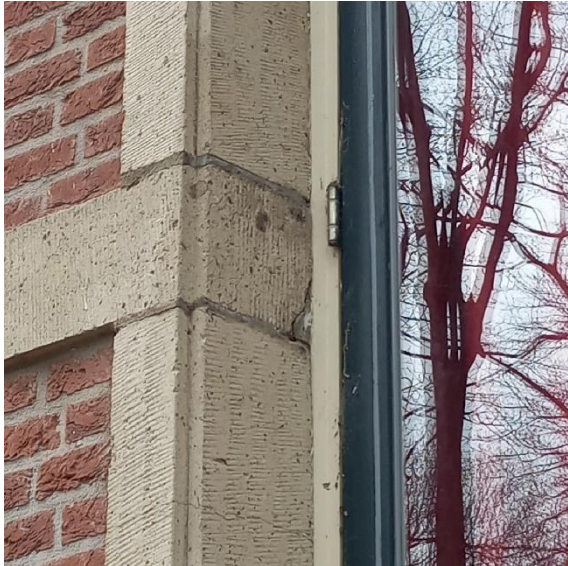
30.4 De voegen tussen de tufsteen zijn te hard en veroorzaken spanningschade aan de tufsteen.
