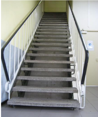
32,1, De afstand tussen de balusters onderling zijn te groot
