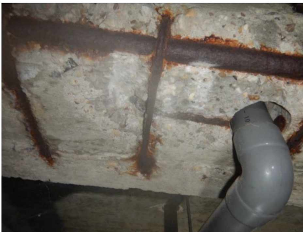
Foto 4.21: Schadebeeld rondom doorvoering, hoofdwapening balk doorboord.
