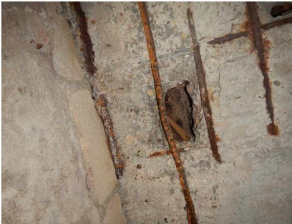
Foto 4.11: Schadebeeld rondom doorvoering.
