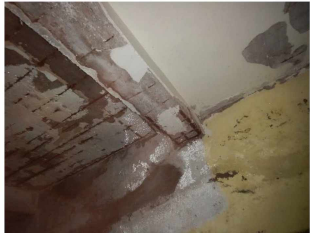
Foto 4.24: Schadebeeld ter plaatse van matig-sterk tot sterk aangetaste delen (ruimte 19).
