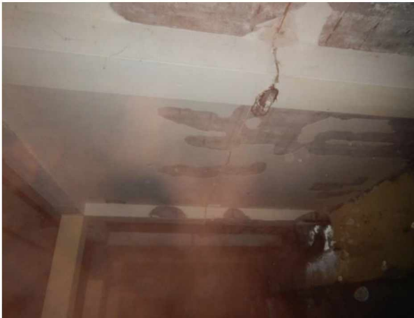
Foto 4.23: Schadebeeld ter plaatse van matig aangetaste delen (ruimte 19).
