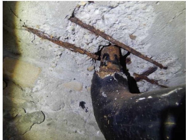
Foto 4.12: Schadebeeld rondom doorvoering.
