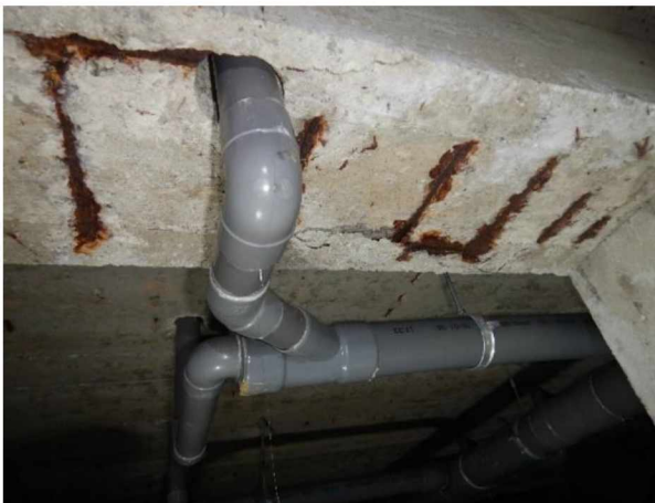
Foto 4.13: Schadebeeld rondom doorvoering, hoofdwapening balk doorboord.
