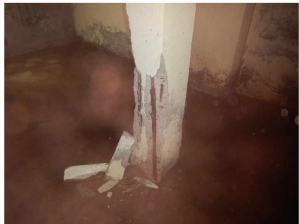
Foto 4.22: Zeer sterk aangetaste kolom 19.1 (ruimte 19).
