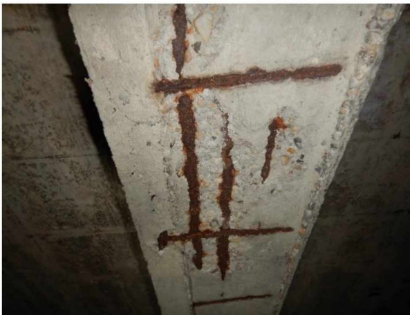
Foto 4.7: Schadebeeld onderzijde balken.
