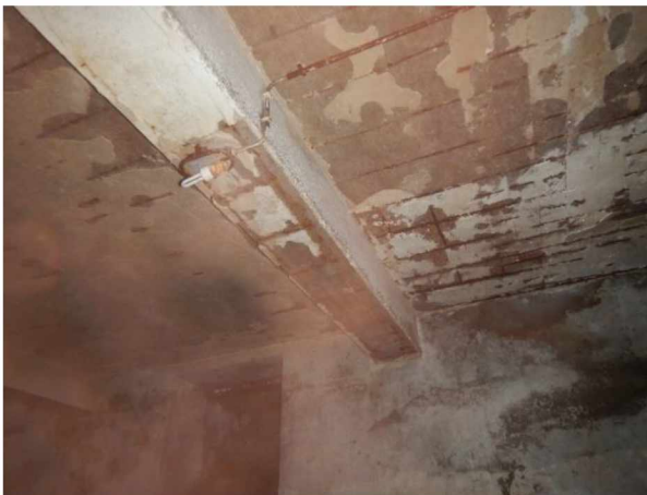
Foto 4.25: Schadebeeld ter plaatse van matig-sterk tot sterk aangetaste delen (ruimte 19).
