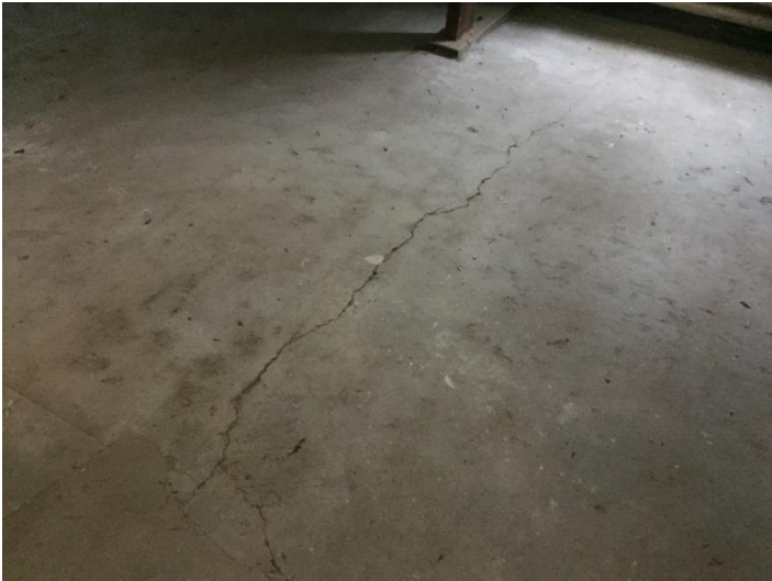
Foto 6: Scheur in (afwerk)vloer
