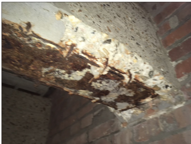
Afb. 54: Destructief onderzoek door de opdrachtgever: De I-balk loopt door in de later aangebrachte betonnen slof.
