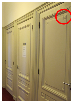
Afb. 117: De deuren voor de facilitaire ruimte 2.6 t/m 2.8 hebben in de bouwtekeningen geen diamantkoppen in de hoeken van de panelen. (Bron bouwtekeningen: GAR 396-01_9968)
