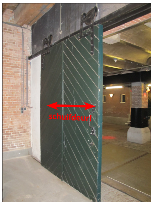
Afb. 78: de pakhuisdeuren zijn vormgegeven als dubbele openslaande deuren, maar zijn stiekem schuifdeuren!
