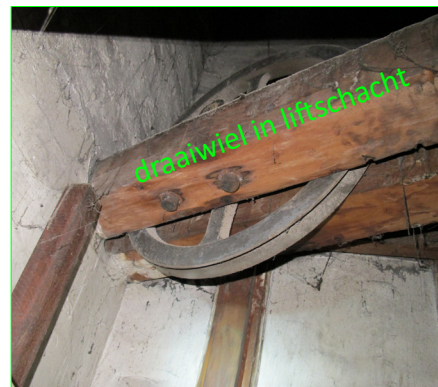
Afb. 130: Het draaiwiel bovenin het liftschachtje (ruimte 2.8a)
