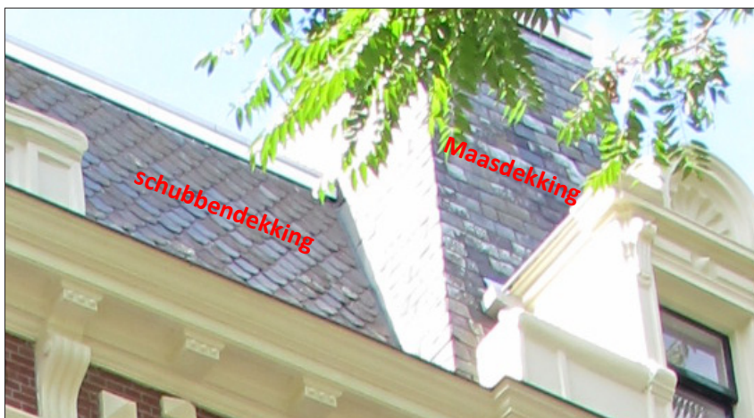
Afb. 90 (linksboven): Schubbendekking op de mansardekap en Maasdekking op de steile kap.
