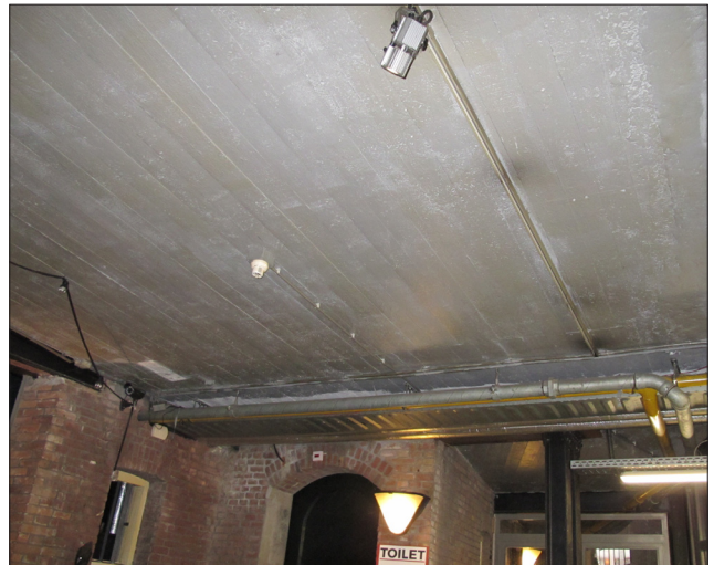
Afb. 57: Vooraan in de onderstraat is het plafond vervangen toen de op- en afritten gewijzigd werden. Hier zijn daardoor geen betonnen troggewelfjes meer op deze plek aanwezig.
