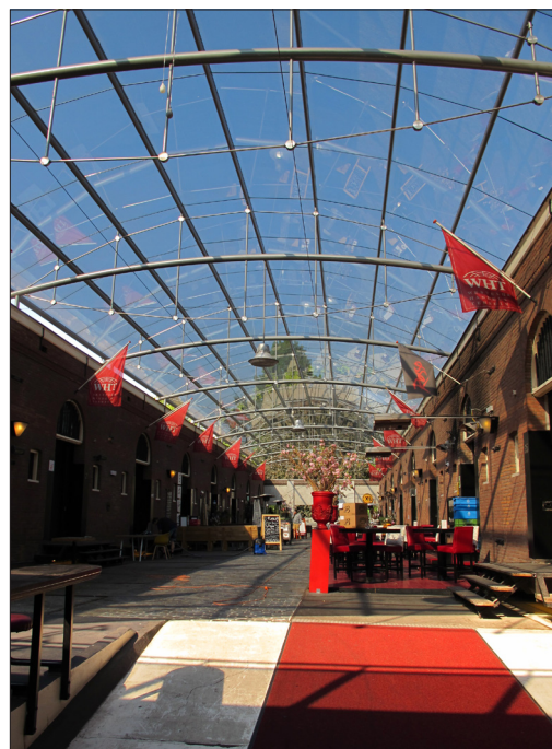
Afb. 16: Bij de verbouwing van 2001 is een grote glazen 'zwevende' kap aangebracht om de bovenstraat af te dekken en er zo een beter klimaat te creëren.
