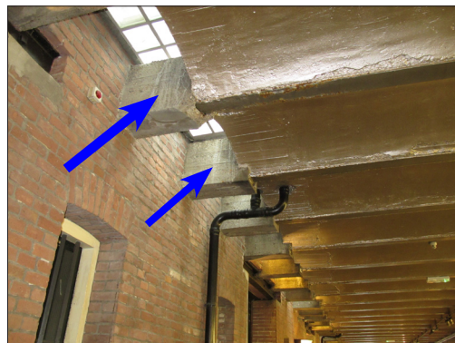
Afb. 15: Betonnen sloffen aan de uiteinden van de ijzeren I-balkjes in de onderstraat.
