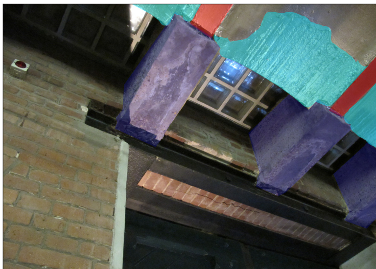
Afb. 53: I-balkjes (rood), betonnen troggewelfjes (lichtblauw) en later aangebrachte betonnen sloffen (donkerblauw).
