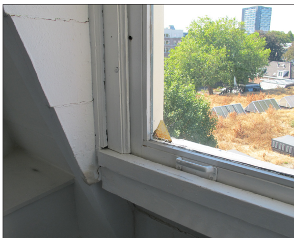
Afb. 73: Oorspronkelijk kozijn in ruimte 3.1, onderdorpel wel vervangen.
