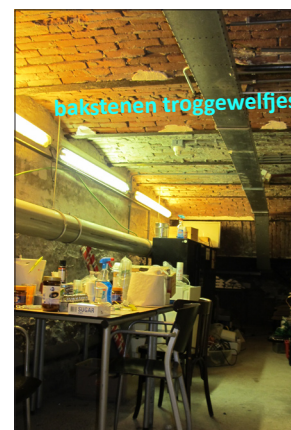
Afb. 48: Ruimte -1.5 in de kelder, met bakstenen troggewelfjes
