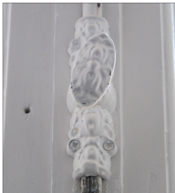
Afb. 66: Het neorenaissance sluitwerk van het raam in de dakkapel van ruimte 3.4 (zolder)
