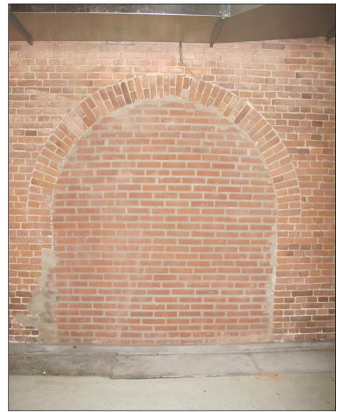
Afb. 36: Dichtgemetselde doorgang in pakhuis 6
