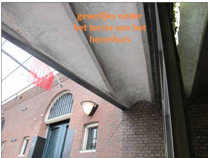
Afb. 58: Ondanks dat ze niet in de bouwtekeningen (vgl. afb. 47) staan zijn er wel betonnen troggewelfjes onder de terrasvloer van het herenhuis aanwezig.
