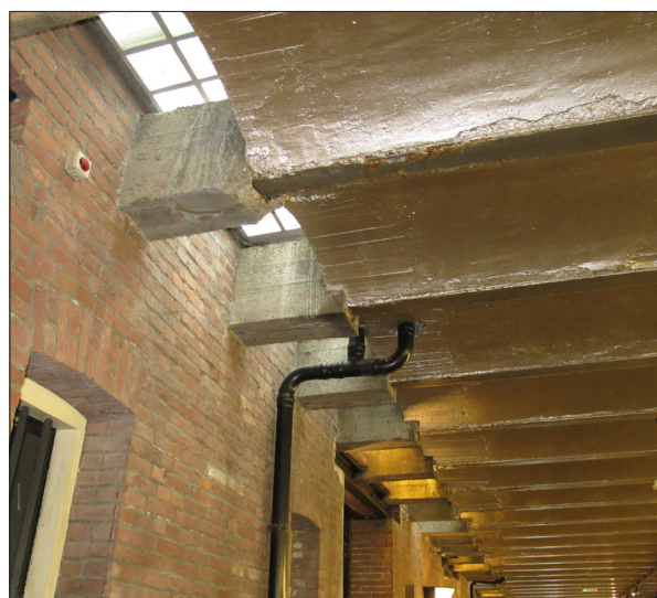
Afb. 50: Plafond van de onderstraat met glazen stenen aan de randen
