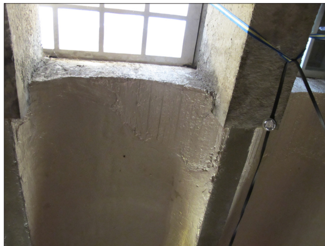
Afb. 55: Een betonnen troggewelfje bekeken van de kopse kant.
