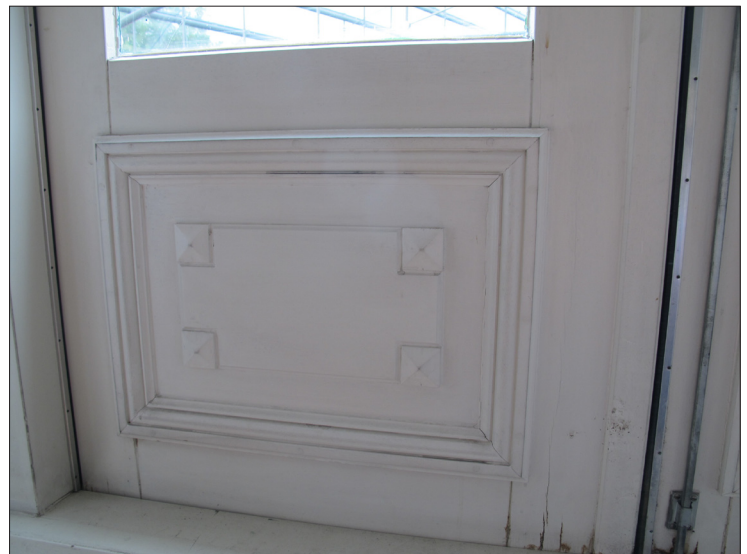
Afb. 126: De bovenzijde van de deur van 3.8 lijkt nieuw, wat erop duidt dat de deur vermoedelijk een reconstructie betreft.
