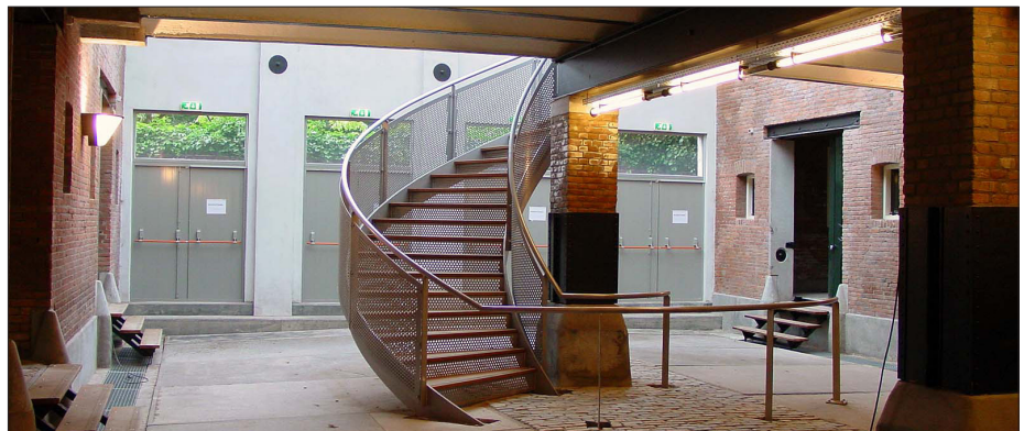
Afb. 105: De in 2001 aangebrachte grote spiltrap aan het einde van de binnenstraat (Bron: Van der Weerd)
