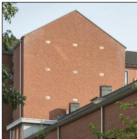
Afb 22 + 23: Gierzwaluwkasten ingemetseld (worden ook gebruikt door Huismussen)
