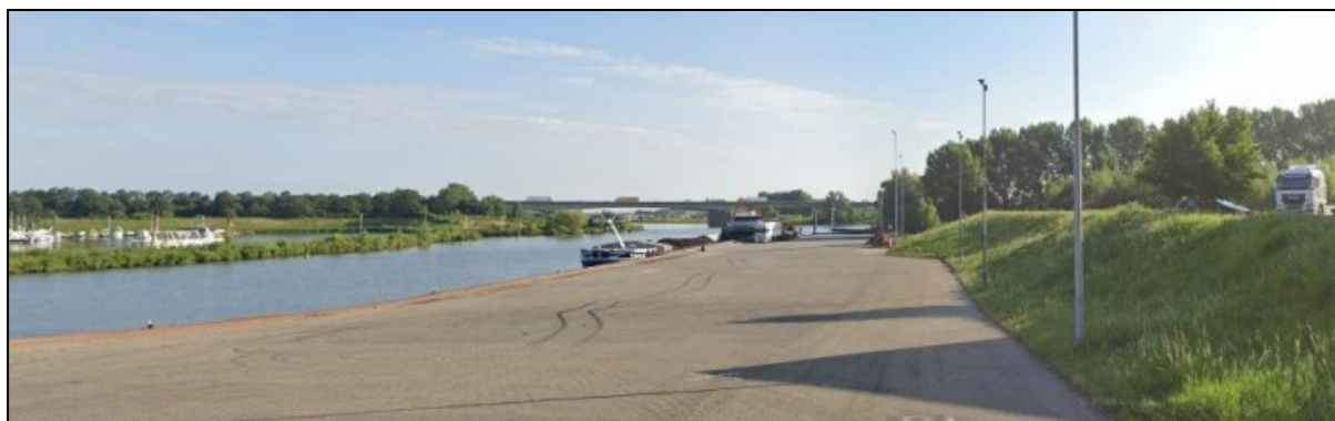
Figuur 2-3 Primaire kering bij loswal: talud met keermuur in de kruin
