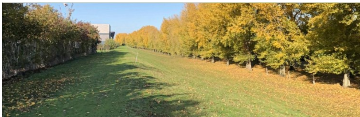
Figuur 2-2 Primaire groene kering: grondlichaam met grasbekleding
