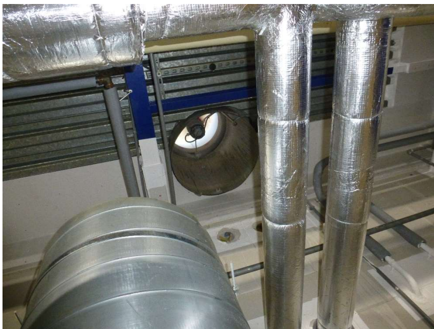
Afvoer warmte persluchtcompressor via dak naar buiten.
