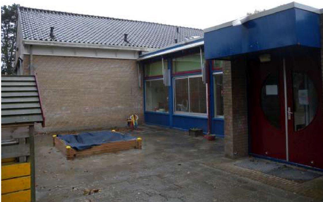
Foto 10 Buitengevel entree met houten en/of trespas aftrimmingen
