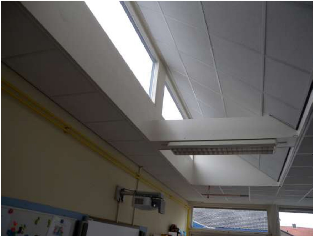
Foto 5 Schuindakconstructie met bovenlichten
