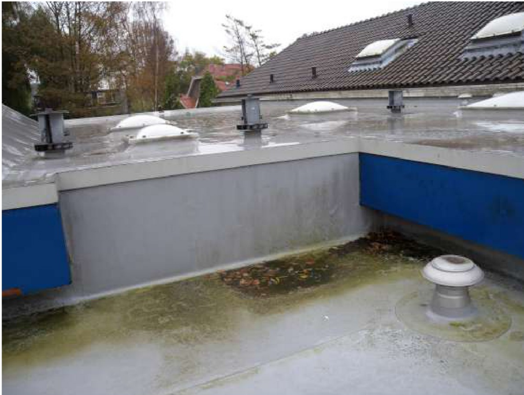
Foto 9 Platdak met kunststofdakbedekking
