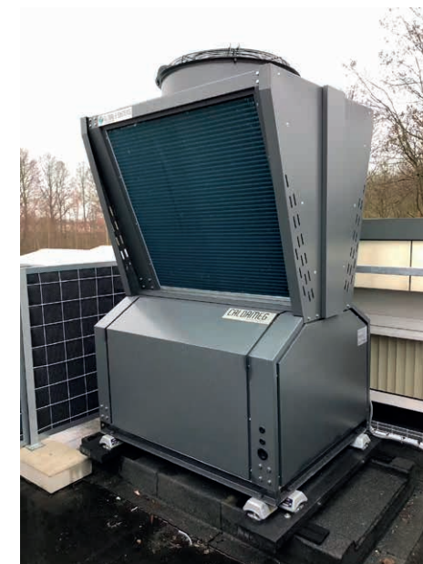
Warmtepomp op het dak: Op het dak van het appartementencomplex worden twee warmtepompen geïnstalleerd, elk met een vermogen van 35 kW.
