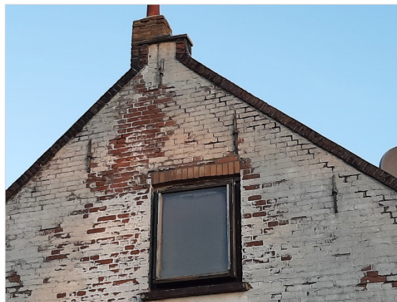
Figuur 5.2. zuidelijke zijgevel van de bebouwing waarbij de kantpannen ontbreken.
