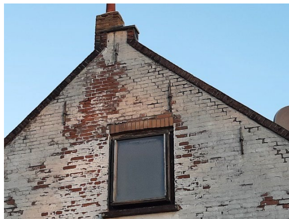
Figuur 64. Zuidelijke zijgevel van de bebouwing waarbij de kantpannen ontbreken.
