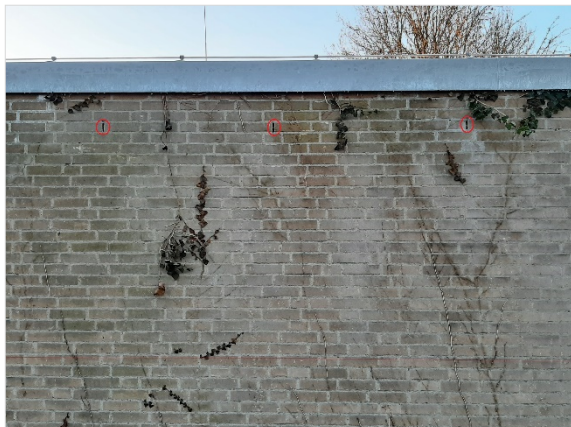
Figuur 5.5. Open stootvoegen in de aangrenzende bebouwing langs de zuidzijde van de onderzoekslocatie (rode cirkels)
