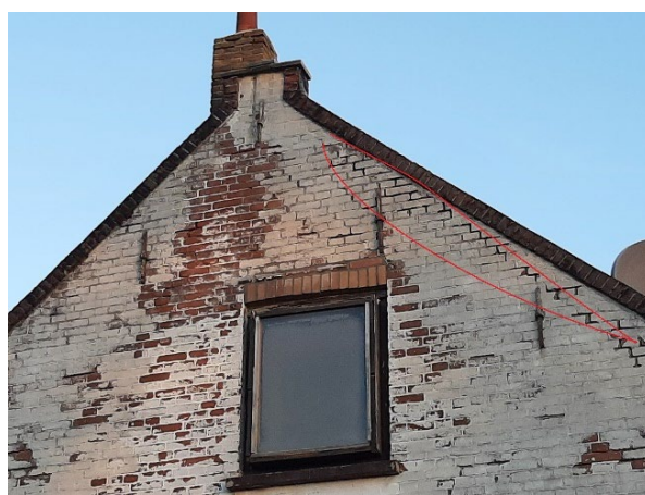
Figuur 13. Zuidelijke zijgevel van Schulpweg 226 met diverse spleten en openingen (rode omlijnning).
