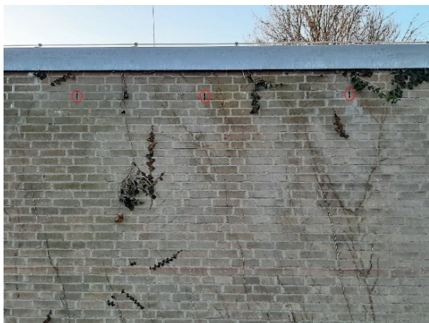
Figuur 14. Open stootvoegen in de aangrenzende bebouwing langs de zuidzijde van de onderzoekslocatie (rode cirkels).
