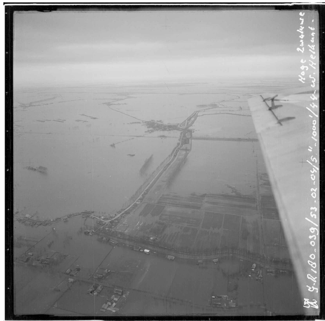
Figuur 26. Hoge Zwaluwe kort na de Watersnoodramp in 1953, gezien vanuit het zuiden. Naar rechtsboven (achter de vliegtuigvleugel) opende het zeegat, waarin de dijkes van de diverse polders te zien zijn. Alle zijn overstroomd (Collectie NIMH, nr. 2152_014_038).
