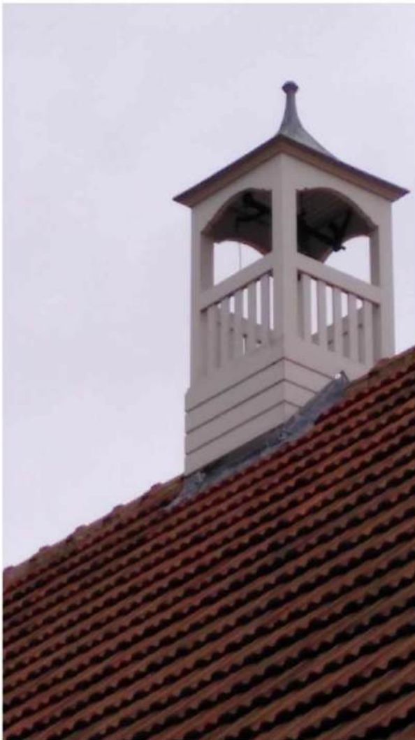
46. Dakruiter met luidklokje op de nok van het zadeldak.
