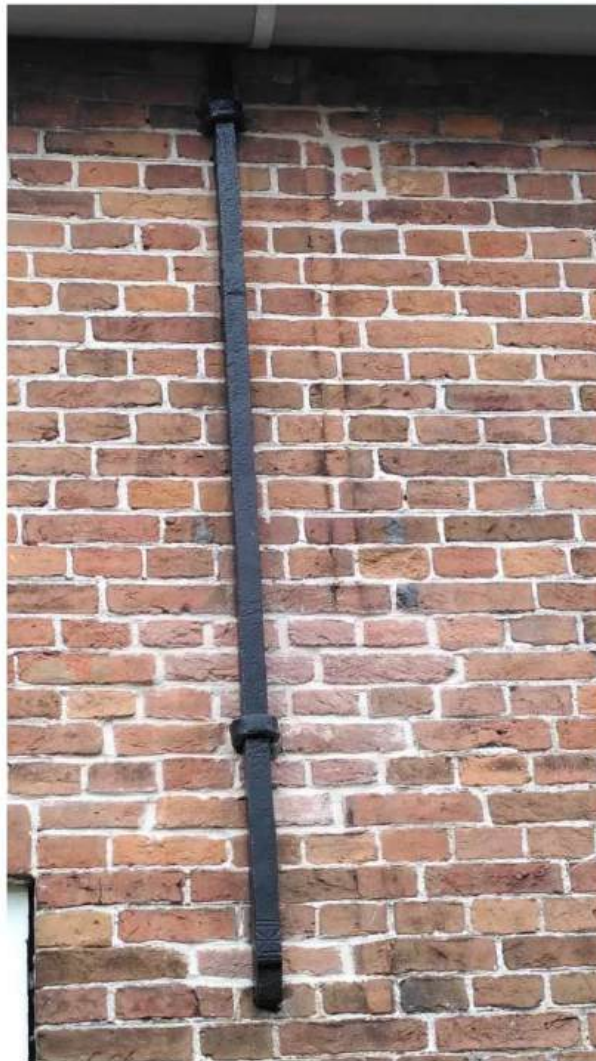
56. Detail met dichtgemaakte ventilatiesparing (boven).
