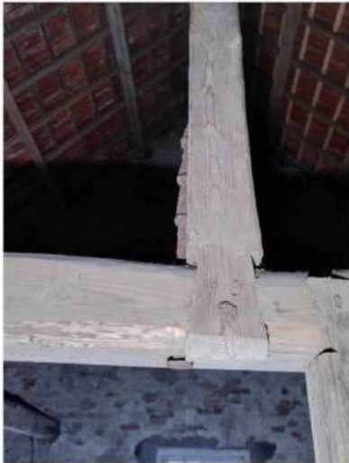
86. Hooizolder, hakkelbout van de nokstijlverbinding.
