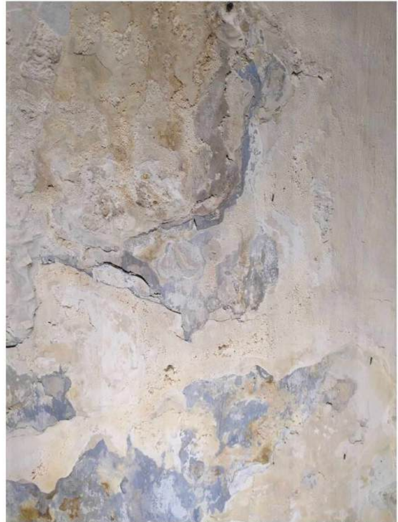
60. Kelder, verschillende kleurafwerkingen op de pleisterlagen.
