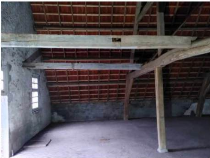
87. Hooizolder, westelijke topgevel met vlieringbalken.
