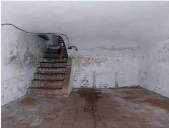
58. Kelder, in het opgaande werk zijn groot formaat bakstenen verwerkt.
