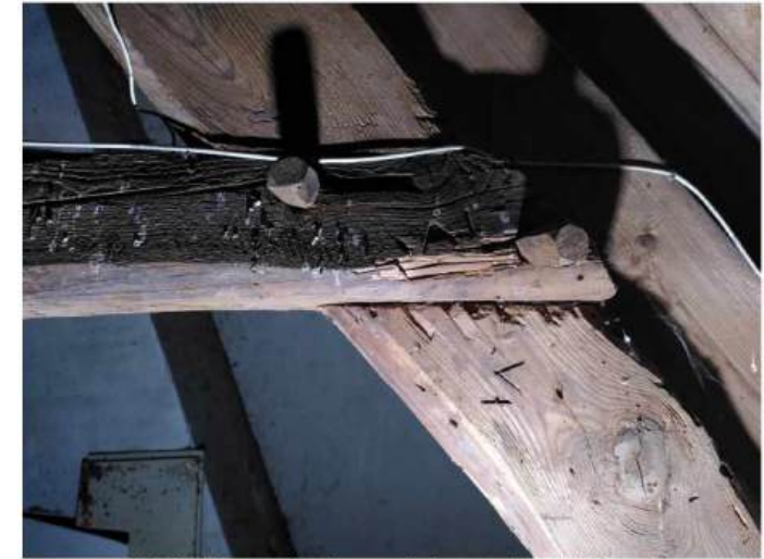
112. Zolderverdieping - vliering, telmerk VI op kapspant.
