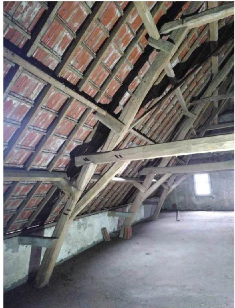
85. Hooizolder, dekbalkjucken.
