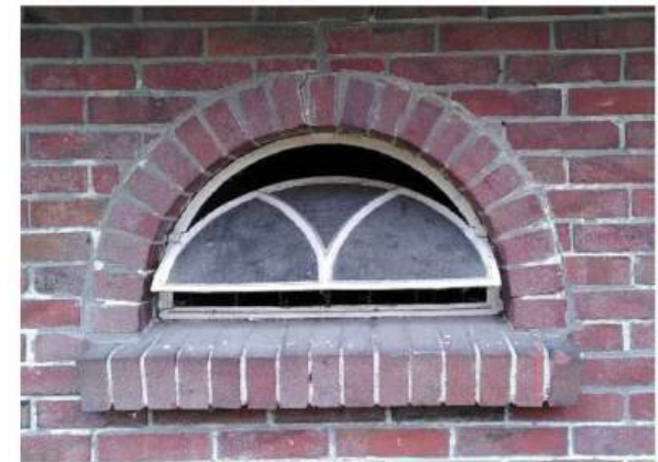
125. Grote schuur, ijzeren tuimelraampje.
