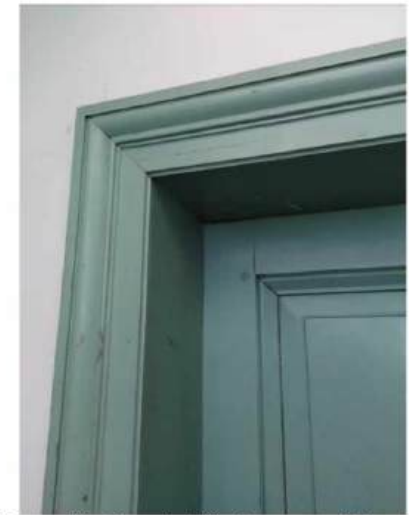
109. Zolderverdieping, detaillering paneeldeur.
