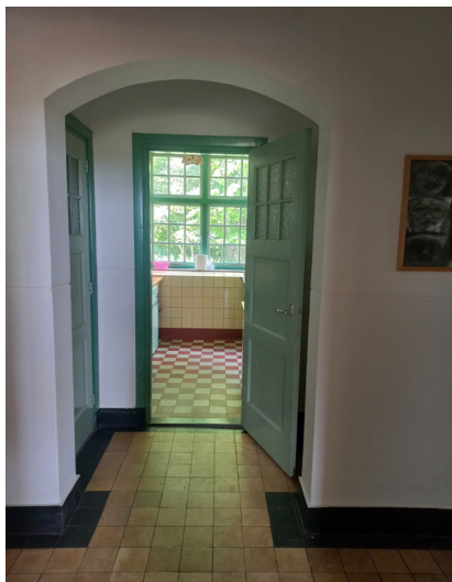
De tegelvloer met zwarte bies en plint in de oorspronkelijke entreehal en gang. Doorkijk naar naar de oorspronkelijke wasruimten met rood-wit geblokte tegelvloer.
