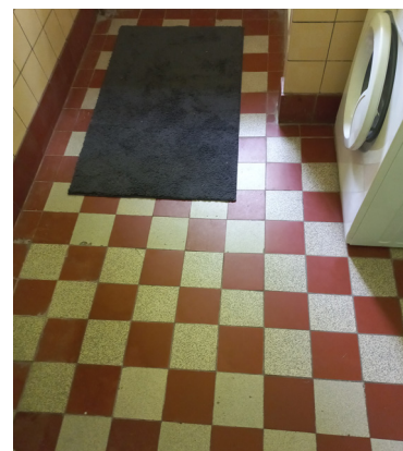
V4 tegelvloer rood schaakbord met rode bies [1942 - gedeelte onder de mat aangevuld in 1951]
