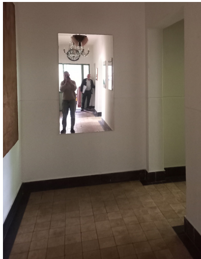
Tussenwand middengang - de zwarte bies van de tegelvloer is onderbroken.
