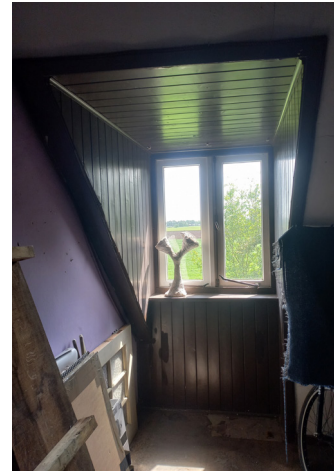
Schrootjes (binnenafwerking dakkapellen)
