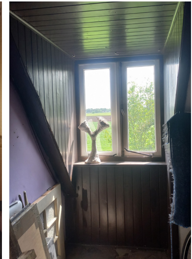
Afwerking binnenzijde dakkapel met houten schrootjes (jaren
