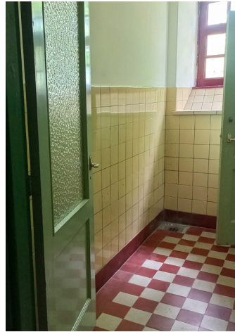
Tegelwerk lambrisering (h=1,5 m)
