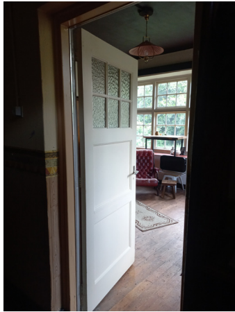
D1 Paneeldeur met bovenlicht (kathedraalglas) 2x3 (1942) - 12x
