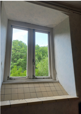
N1 Getegelde vensterbanken met vorm elementen schuine negges, onderkant schuin aflopend
