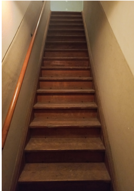
T1 Houten steektrap met houten leuning aan MW wanden - traploper transparant bruin afgewerkt [1942]
