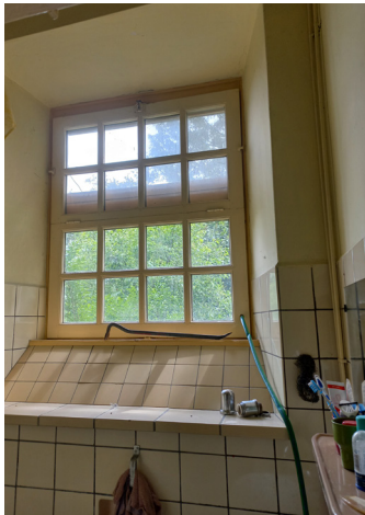
N1 Getegelde vensterbanken met vorm elementen schuine negges, onderkant schuin aflopend
