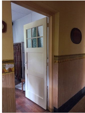
D1 Paneeldeur met bovenlicht (kathedraalglas) 2x3 (1942) - 12x
