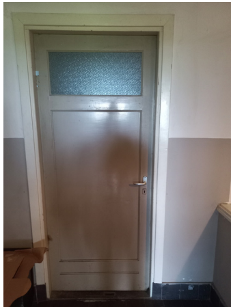
D2 Kastdeur dicht met bovenlicht (kathedraalglas)
