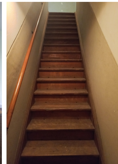
Oorspronkelijke houten steektrap met eenvoudige profilering.
