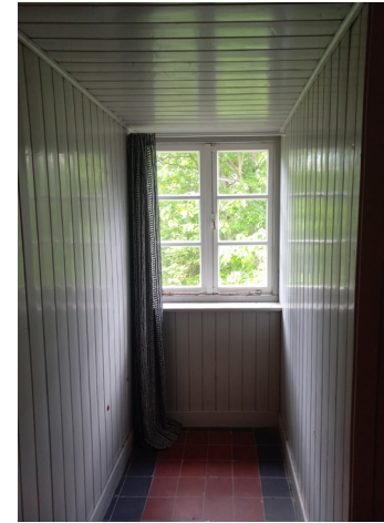
Schrootjes (binnenafwerking dakkapellen)
