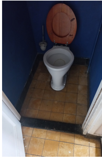
Ingepast toilet in de middengang - vloertegels zijn behouden. De paneeldeur is mogelijk hergebruikt van elders op het complex.
