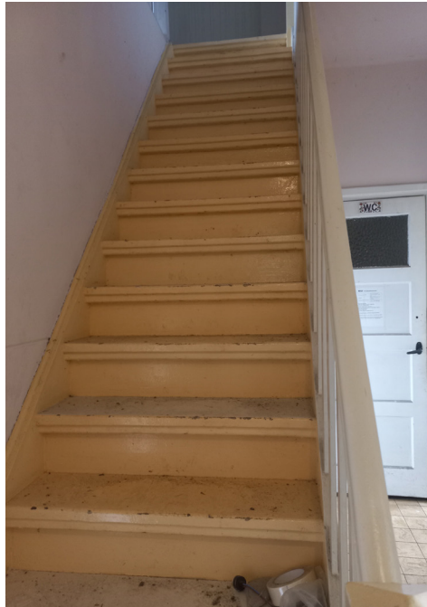
T2 Houten steektrap [1951] - eenzijdig open vv houten spijlen hekwerk.
