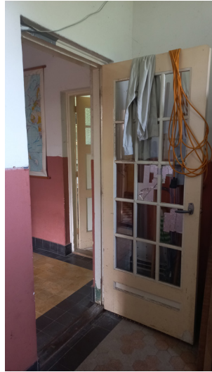
Entreehal met rood/grijze hexagon-vormige vloertegels met zwarte bies en plint en deur met ruiten/roedeverdeling richting de middengang.
