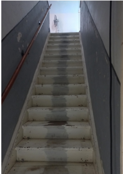
T1 Houten steektrap met houten leuning aan MW wand - traploper wit afgewerkt [1942]
