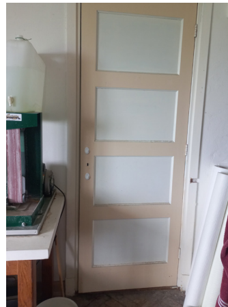
K Dichte kastdeur (paneeldeur met vierdeling)
