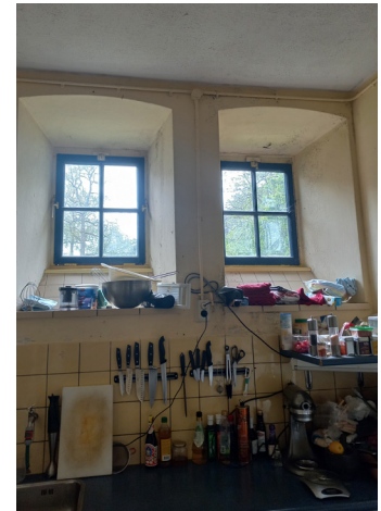
Getegelde vensterbanken met vorm elementen schuine negges, onderkant schuin aflopend
