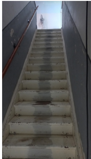
Eenvoudige steektrap naar de overloop op zolder.
