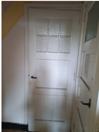
D1 Paneeldeur met bovenlicht (kathedraalglas) 2x3 (1942) - 8x
