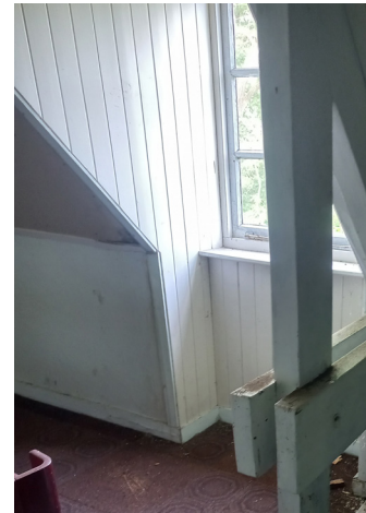
Schrootjes (binnenafwerking dakkapellen)
