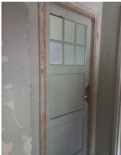
Oorspronkelijke paneeldeur met bovenlicht.
