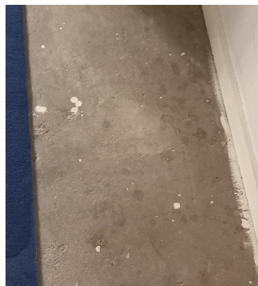
V10 Betonnen vloer onafgewerkt (1942)
