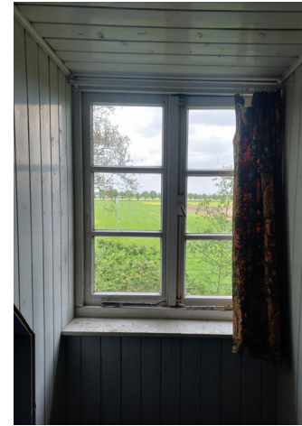
Schrootjes (binnenafwerking dakkapellen)
