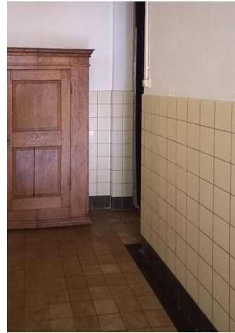
Tegelwerk lambrisering - geel met zwarte plint (h=1,5 m)
