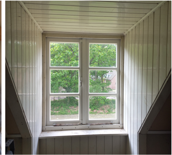
Afwerking binnenzijde dakkapel met houten schrootjes (jaren '70).
