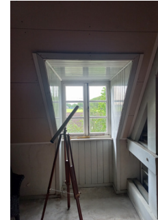
Binnenafwerking dakkapellen zolderverdieping in houten schroten (jaren '70).
