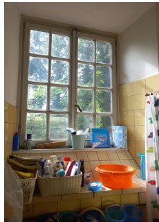
N1 Getegelde lambriseringen in de keukens en natte ruimten tot 1,80 m. hoog. Vensterbanken met schuine negges, onderkant schuin aflopend (1951)
