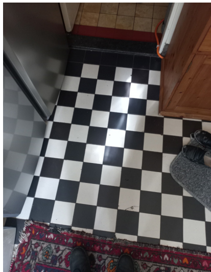
Zwart-wit geblokte tegelvloer met zwarte bies en lichtgele tegellambrisering een van de keukens.
