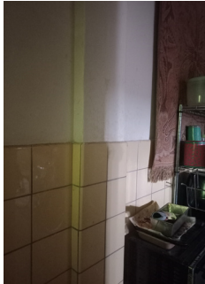
Lambrisering in lichtgeel tegelwerk de middengang (BG) ca 1,5m hoog (1942)
