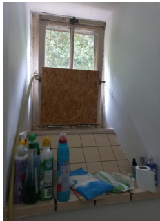
N1 Getegelde lambriseringen in de keukens en natte ruimten tot 1,80 m. hoog. Vensterbanken met schuine negges, onderkant schuin aflopend (1951)
