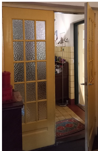
De tegelvloer met zwarte bies en plint in de oorspronkelijke entreehal; deze is ook nog aanwezig in de later geplaatste toilet (1951). Dubbele Bruynzeeldeuren en betonemaille lambriseringen met zwarte tegelrand in de hal.
