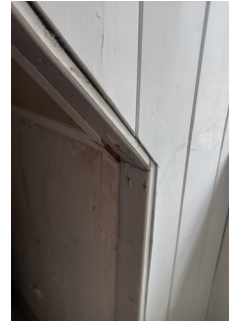
Binnenafwerking dakkapellen zolderverdieping in houten schroten (jaren '70).
