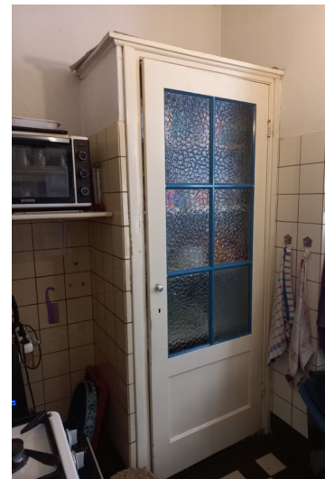
Ingebouwde kast met Bruynzeel-paneel deur in een van de keukens. De betegeling is doorgezet in de raamnissen.
