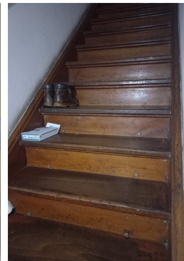
Oorspronkelijke houten steektrap met eenvoudige profilering.
