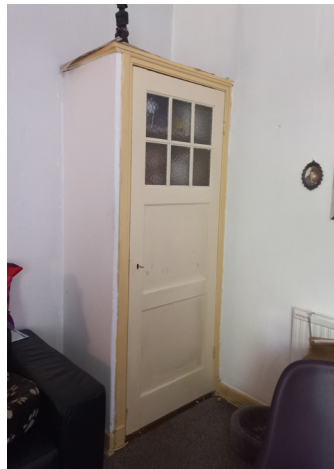
K inbouwkast met paneeldeur met roedeverdeling en ruiten in kathedraalglas (1951 - mogelijk herplaatst vanuit andere logiesgebouwen).
