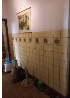
Lambrisering in lichtgeel tegelwerk de middengang (BG) ca 1,5m hoog (1942)
