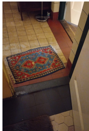
Gevlamde tegelvloer met rode tegelbies en -plint met daarboven een hoge lichtgele tegellambrisering in de middengang.
