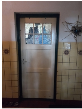
D1 Paneeldeur met bovenlichten 2x3 met kathedraalglas (1942)
