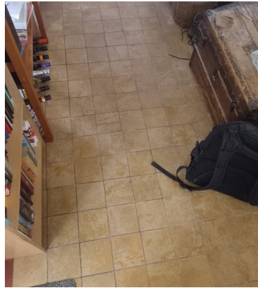
V 2 gevlamde tegelvoer 15x15 - met rode bies en plint (1942)
