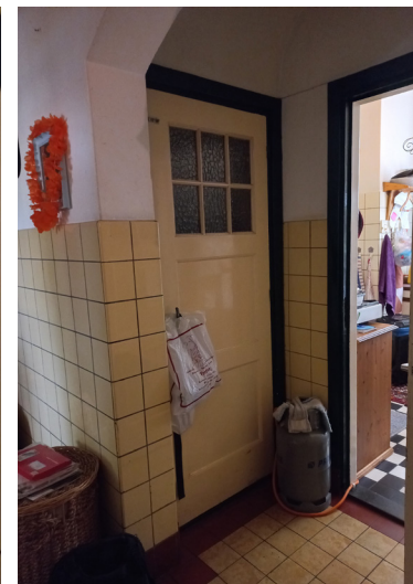
Gevlamde tegelvloer met rode tegelbies en -plint met daarboven een hoge lichtgele tegellambrisering in de middengang.
