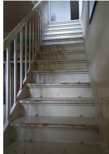
T2 Wit geschilderde houten steektrap (1951) - houten bomen inge- metseld in MW wanden - eenzijdig open w houten spijlen hekwerk (ongeprofileerd rechthoekig profiel) - vierkante ongeprofileerde ballusters.
