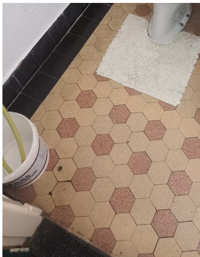
De tegelvloer met zwarte bies en plint in de oorspronkelijke entreehal; deze is ook nog aanwezig in de later geplaatste toilet (1951). Dubbele Bruynzeeldeuren en betonemaille lambriseringen met zwarte tegelrand in de hal.
