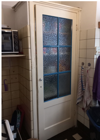
K inbouwkast met paneeldeur met roedeverdeling en ruiten in kathedraalglas (1951 - mogelijk herplaatst vanuit andere logiesgebouwen).
