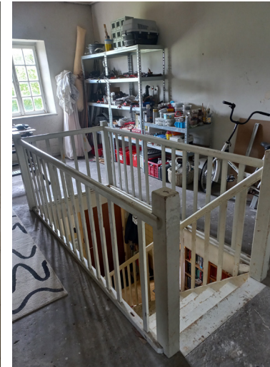
T2 Wit geschilderde houten steektrap (1951) - houten bomen inge- metseld in MW wanden - eenzijdig open w houten spijlen hekwerk (ongeprofileerd rechthoekig profiel) - vierkante ongeprofileerde ballusters.
