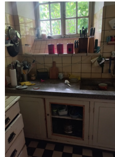
N1 Getegelde lambriseringen in de keukens en natte ruimten tot 1,80 m. hoog. Vensterbanken met schuine negges, onderkant schuin aflopend (1951)
