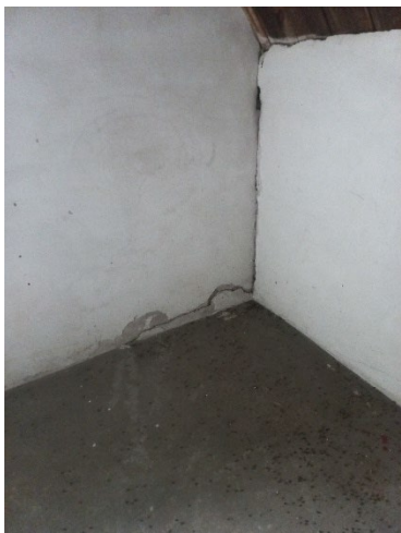
22.17 Scheuren vanaf de spant, loopt horizontaal door over de voorgevel
