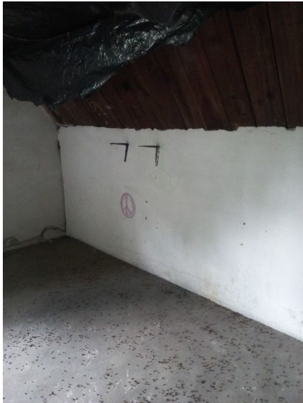
22.17 Scheuren vanaf de spant, loopt horizontaal door over de voorgevel
