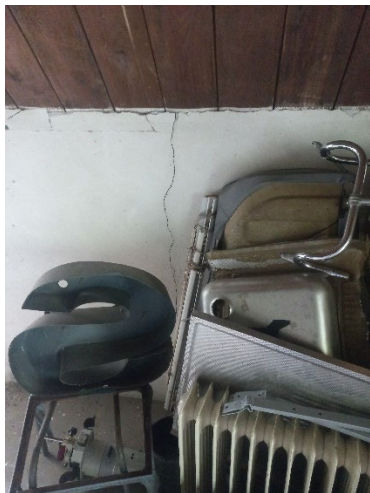
22.17 Verticale scheur in de achtergevel
