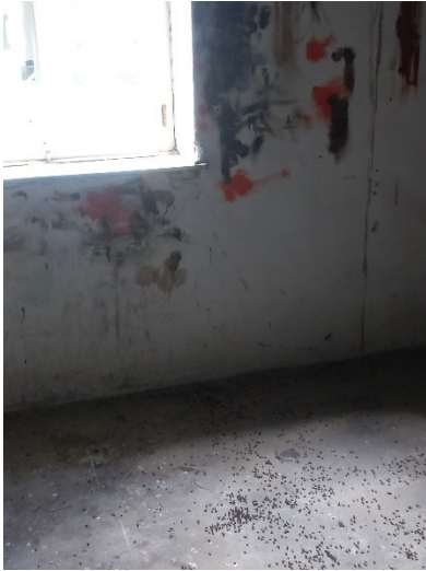
22.17 Scheur in het metselwerk in zijgevel rechts
