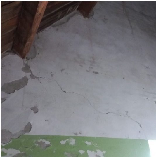
22.17 Scheur in zijgevel rechts (vanaf achtergevel)
