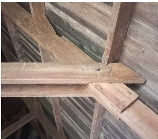
24.3 Twee spanten zijn op een wat eigenaardige manier aangelast
