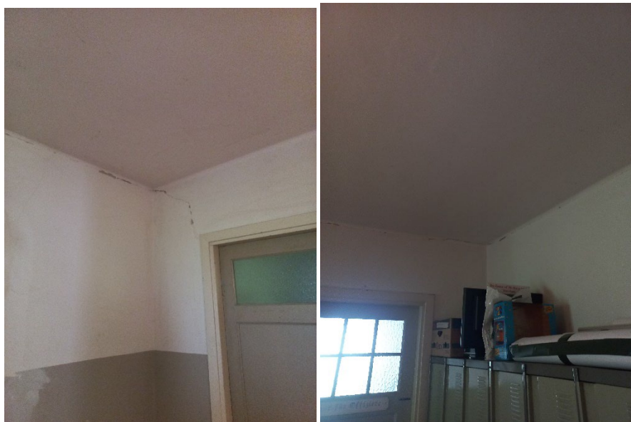
22.16 Scheur loopt helemaal rondom de kamer
