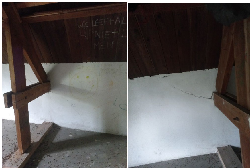
22.16 Scheur loopt helemaal rondom de kamer
