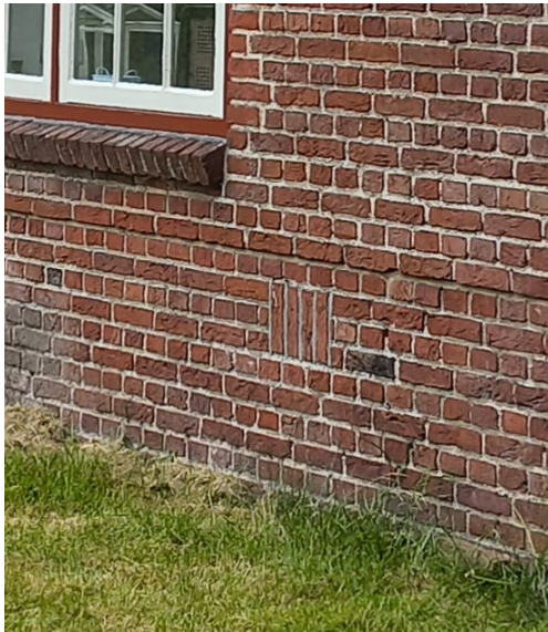
22.4 Een aantal ventilatieopeningen zijn dichtgemetseld
