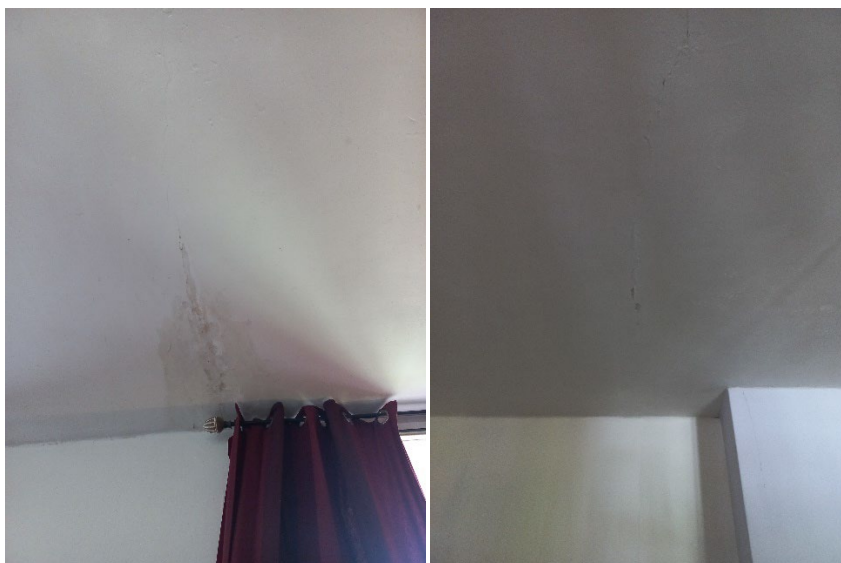
21.3 Een scheur in het stucwerk, loopt vanaf de buitenmuur, met vochtschade richting de binnenmuur door.
