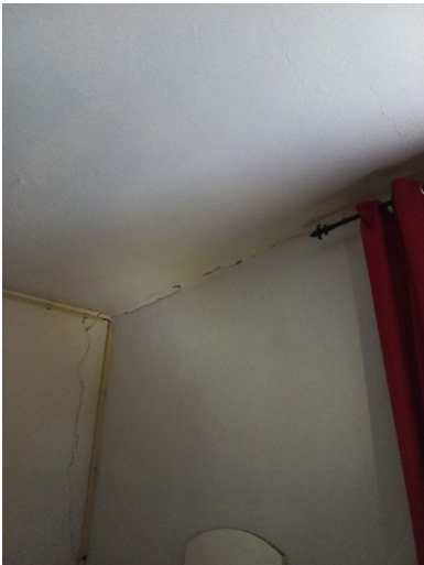
22.8 Horizontale scheur over de hele breedte in de linkergevel op de verdieping
