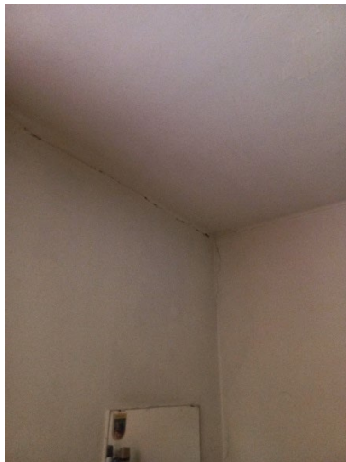
22.8 Horizontale scheur over de hele breedte in de linkergevel op de verdieping
