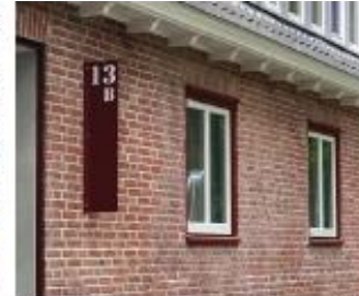
nieuwe binnendraaiende ramen in originele kozijnen
