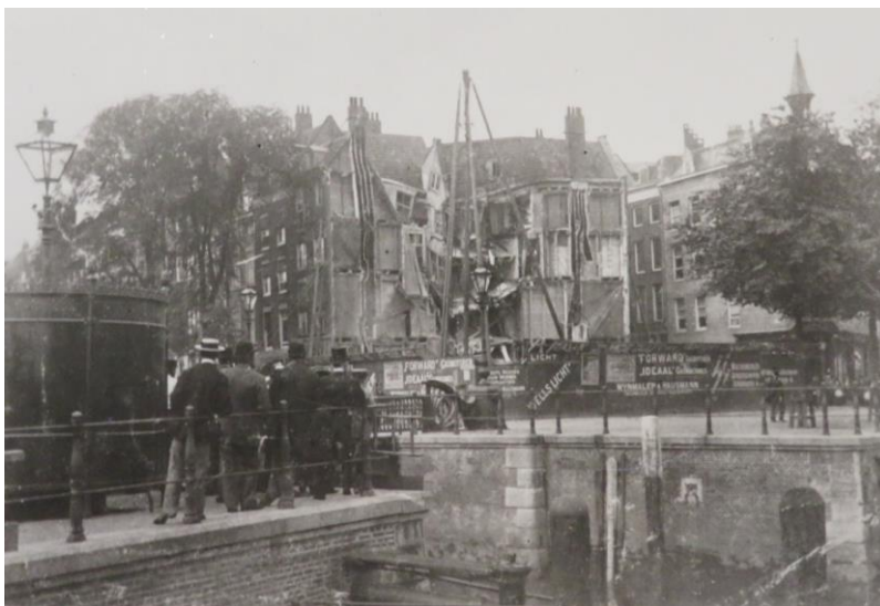
Links: het tijdens de heiwerkzaamheden ingestorte buurpand in 1897. (collectie Stadsarchief Rotterdam)
