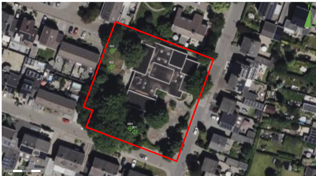
Afbeelding 2: Luchtfoto met onderzoekslocatie en ligging boorpunten infiltratieonderzoek
