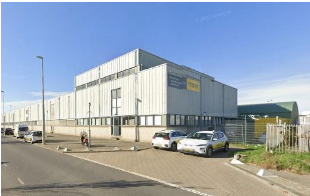
Zuidzijde besluitgebied, grenzend aan de Keileweg, kijkend naar één van de twee bedrijfspanen
