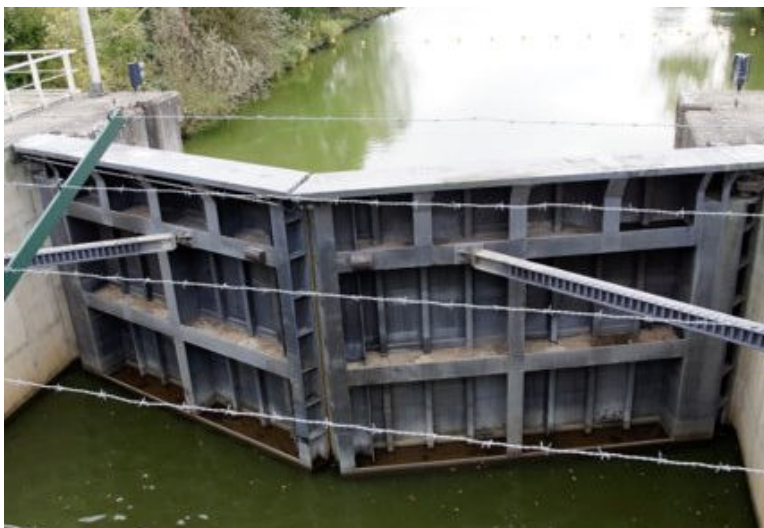
Figuur 2-3: Foto van de stalen puntdeuren
