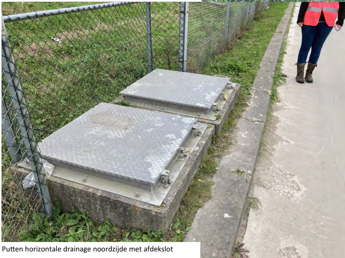
Percolaatput met toegang tot percolaatdrainage
