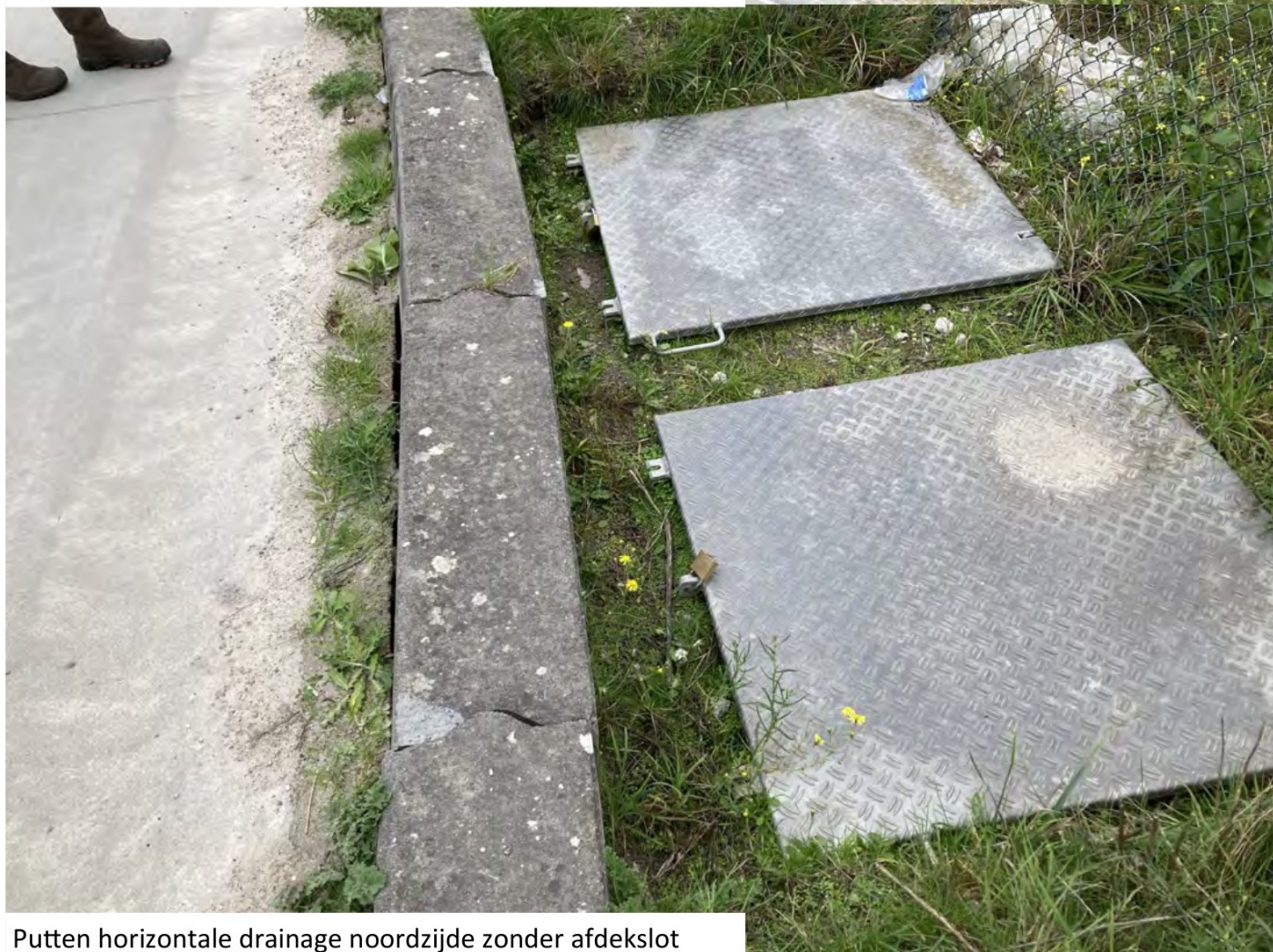
Putten horizontale drainage noordzijde zonder afdekslot
