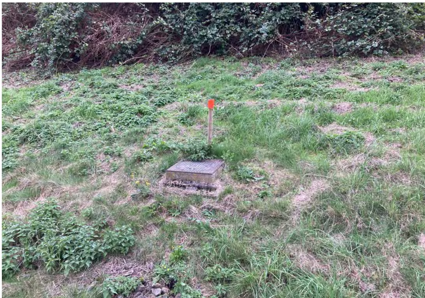
Percolaatput met toegang tot percolaatdrainage
