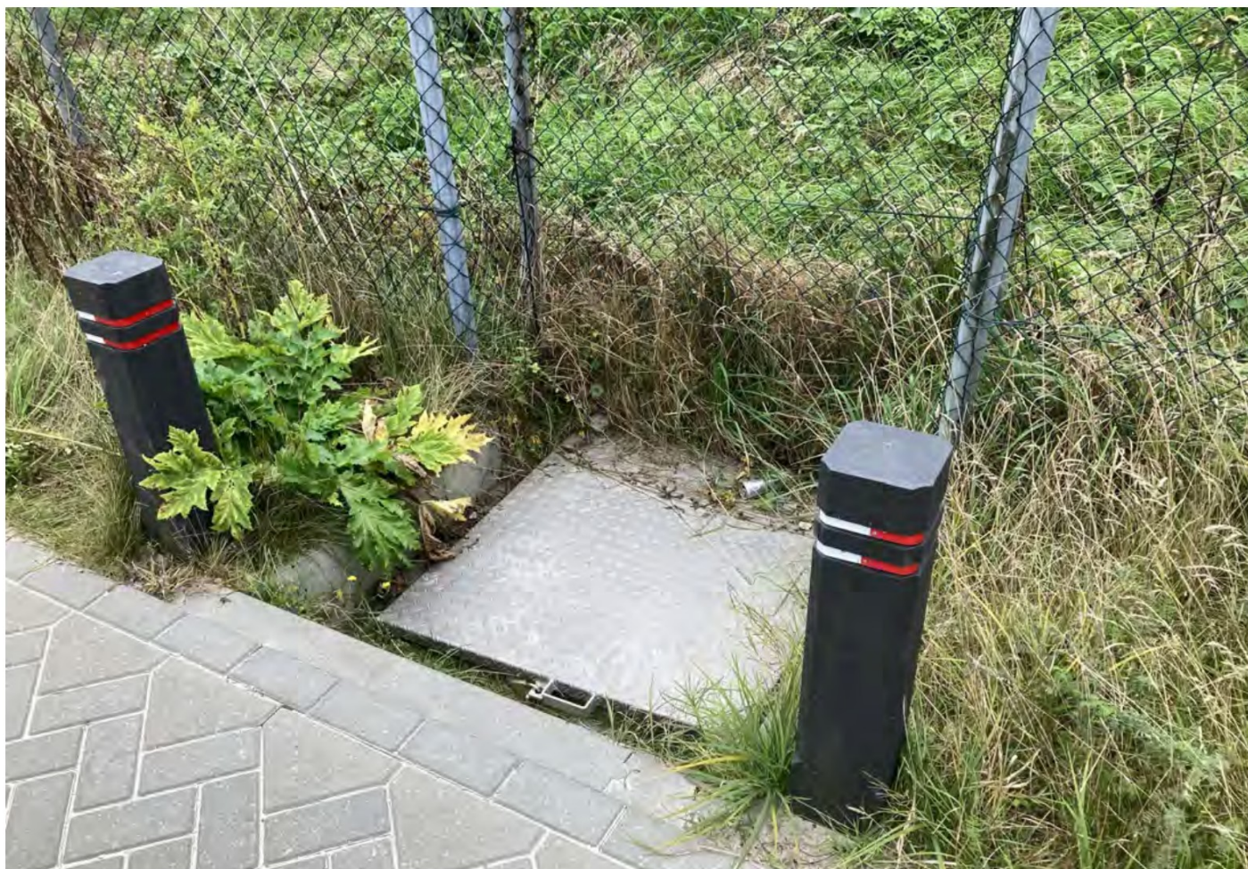
Putten horizontale drainage noordzijde zonder afdekslot
