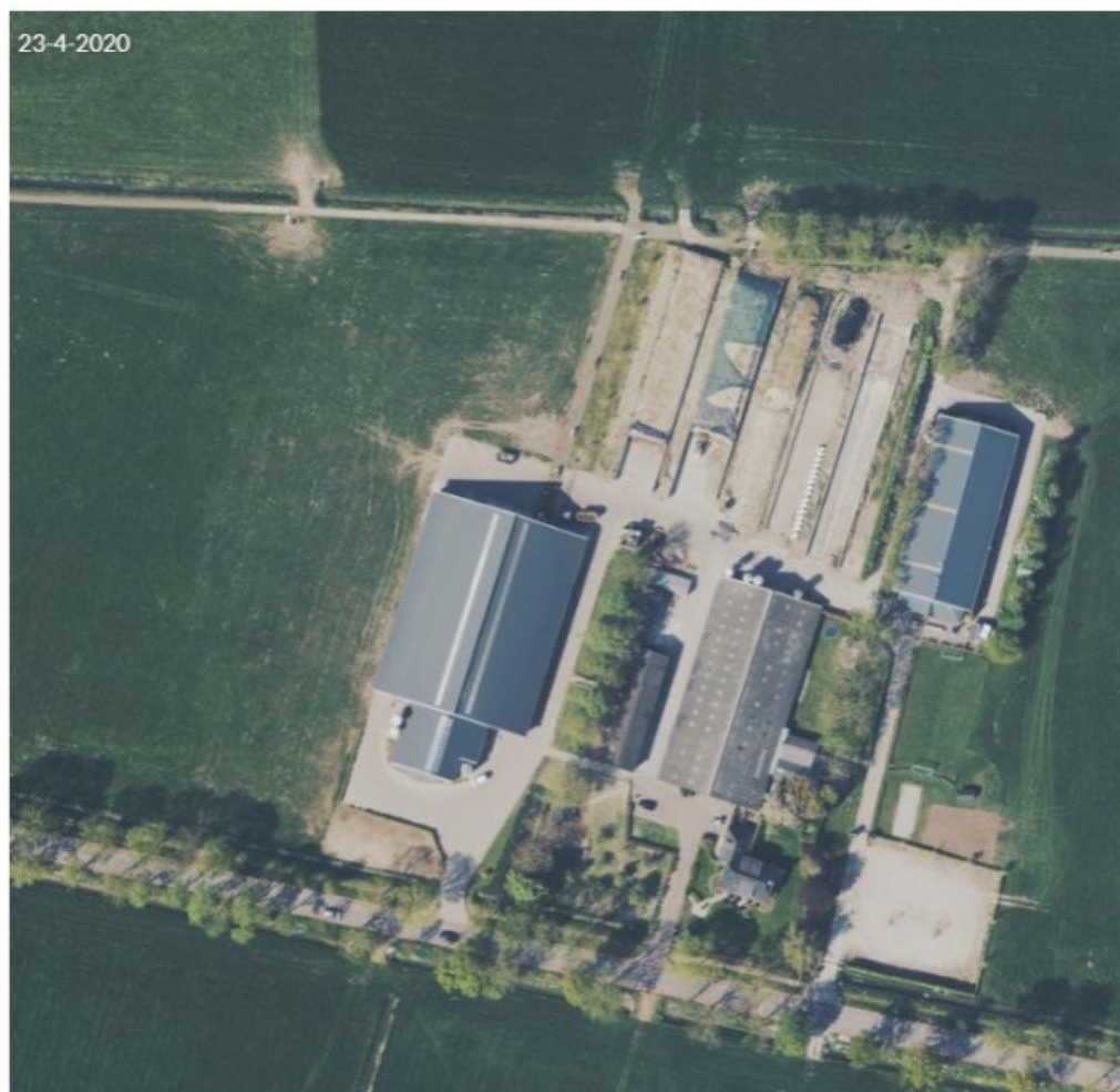
Figuur 1: luchtfoto projectlocatie Achterdijk 57 te Hedel (bron: Cyclomedia)
