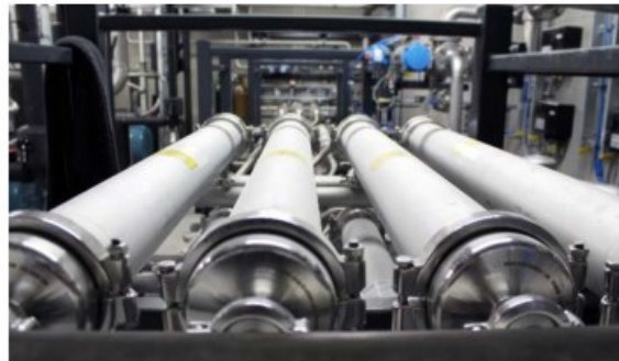
Membraanmodules in een container
