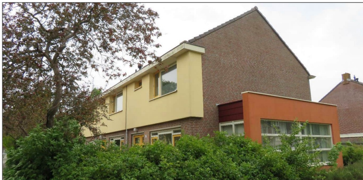
Afb 5: Woonblok met deels buitengevelisolatie
