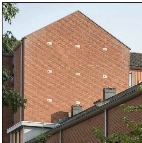
Afb 18 + 19: Gierzwaluwkasten ingemetseld (worden ook gebruikt door Huismussen)
