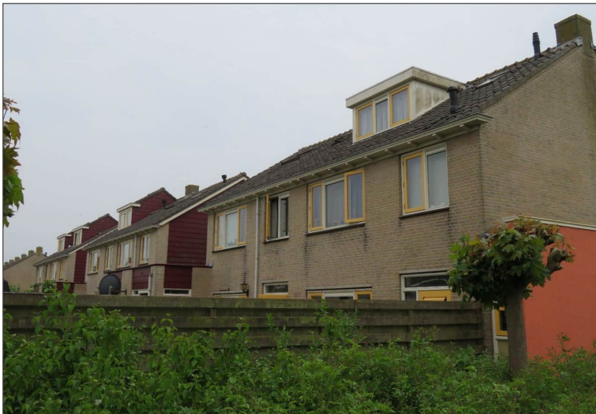
Afb 7: Bij dit woonblok zijn toendertijd minder werkzaamheden verricht (geen rabat, andere dakkapel)
