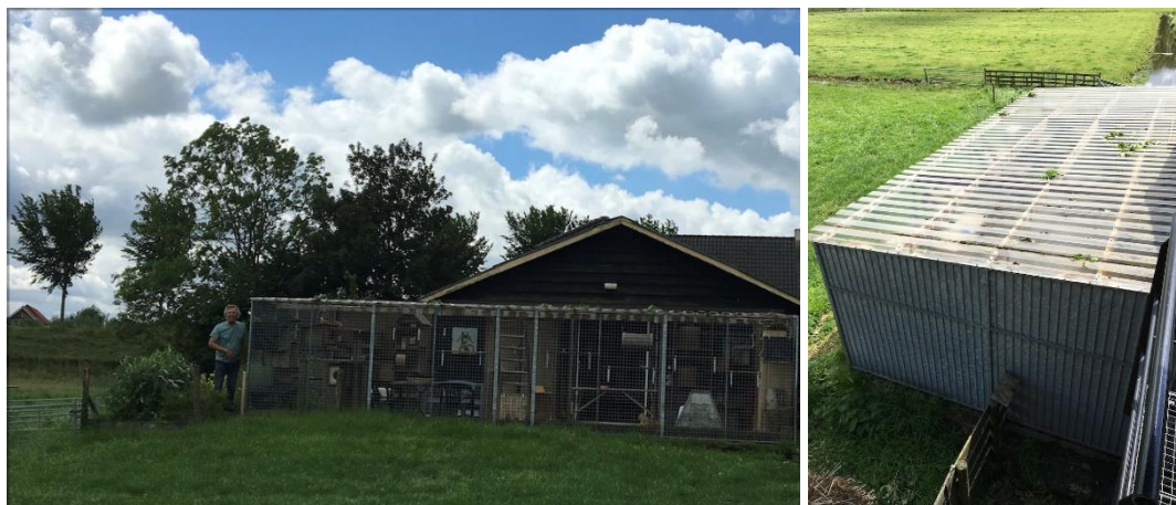
Figuur 3 gesloopte buitenverblijven katten, bron: eigen fotomateriaal
