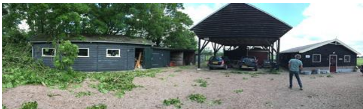
Figuur 5 (panorama)zicht op de schuurtjes, de kapschuur en het kattenpension, bron eigen fotomateriaal
