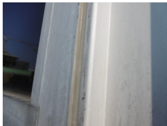
Foto 13 & 14: De afdichtingen en de visuele kwaliteit van het aluminium en het zetwerk is sterk afgenomen..
