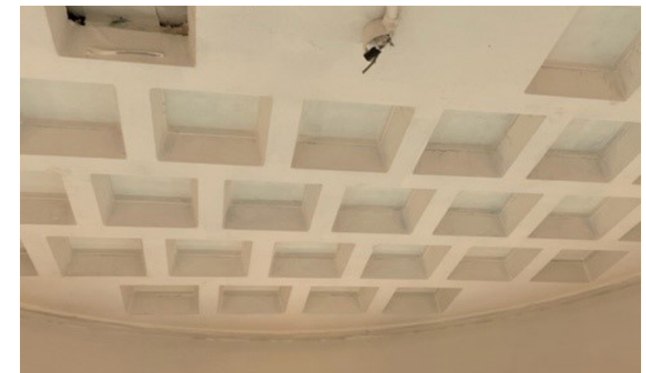
foto bestaande situatie 2022, daklichten vanaf onderzijde
