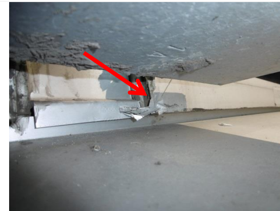
Foto 19 & 20: Verspreid over de gevel zijn diverse openingen zichtbaar tussen de verschillende onderdelen van de gevelconstructies.
