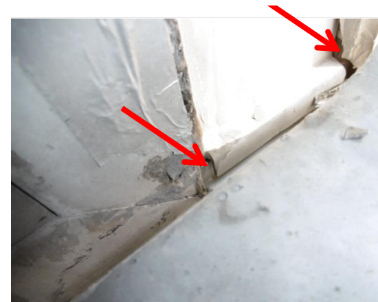
Foto 19 & 20: Verspreid over de gevel zijn diverse openingen zichtbaar tussen de verschillende onderdelen van de gevelconstructies.
