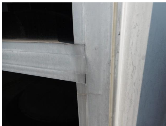
Foto 13 & 14: De afdichtingen en de visuele kwaliteit van het aluminium en het zetwerk is sterk afgenomen..
