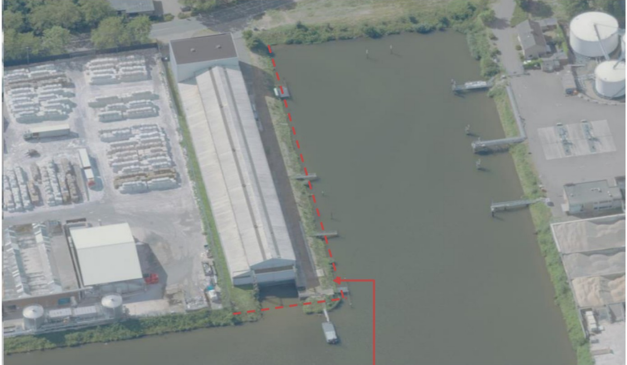
Nieuwe kade lijn, de kade blijft binnen het huidige talud.
