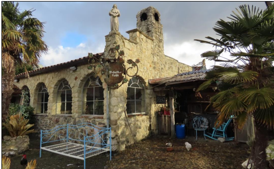
Figuur 1.2 Vooraanzicht van het te saneren pand. De voedselplaatsen van de kippen vormen tevens een voedselbron voor de huismus.
