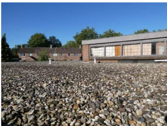
Figuur 5.3 Platte dak met kiezelstenen.
