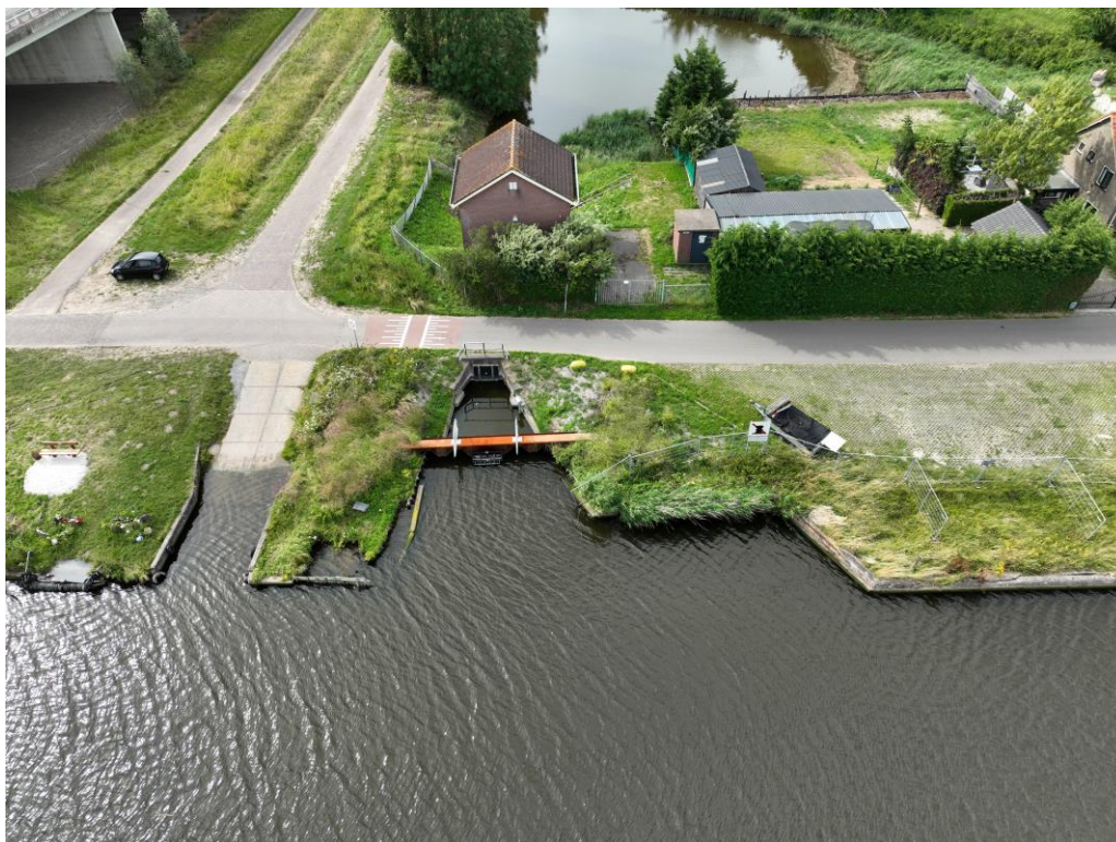
Afbeelding 2: bovenaanzicht huidige gemaal vanaf de boezem
