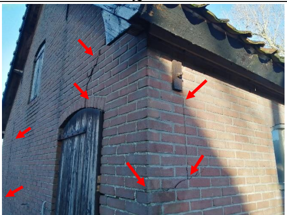
Rondom in de gevels varkensschuur scheurvorming
