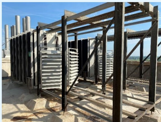
figuur 9: foto van recentelijk gereinigde Ergon-uitlaatroosters
