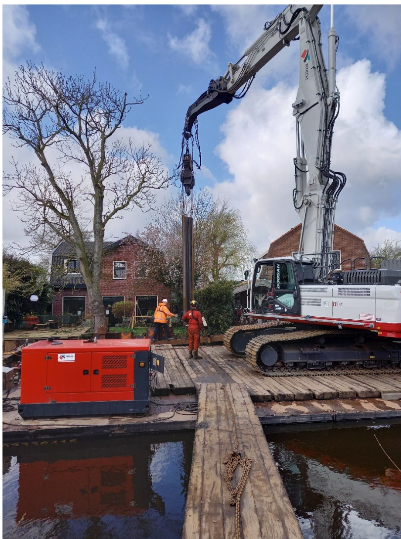
Figuur 3-1 Impressie van het realiseren van een damwand
