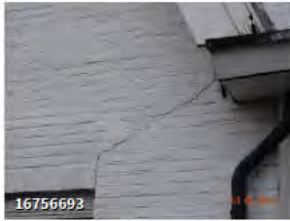
↳ Lichte scheur rechtsonder (1 foto)
