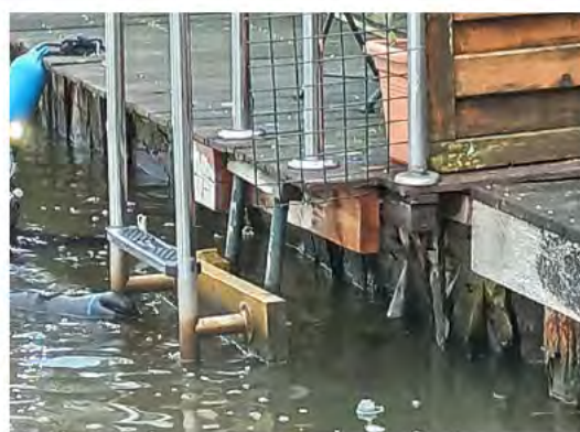
Figuur 67. Houten damwand
