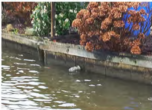
Figuur 81. Houten damwanden
