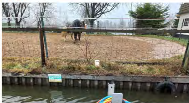
Figuur 77. Overzicht verticale oever staalplaat
