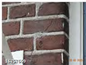
↳ Lichte scheur dubbele deuren rechts linksboven (1 foto)
