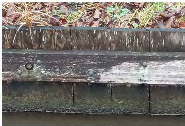
Figuur 63. Houten damwand
