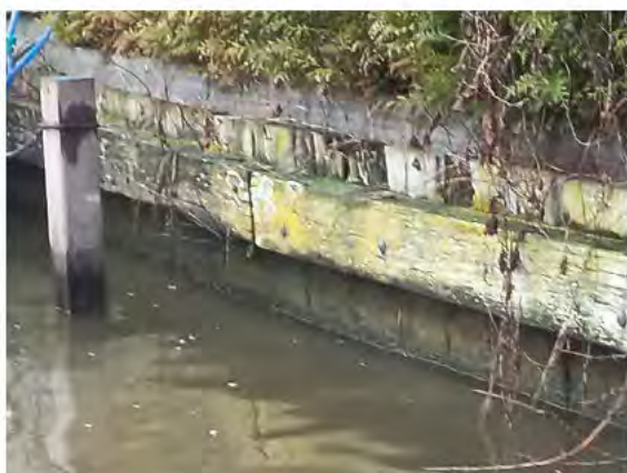
Figuur 39. Verrotte houten damwandplanken
