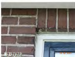
↳ Lichte scheur dubbele deuren rechts linksboven (1 foto)
