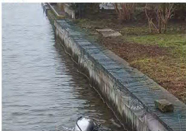
Figuur 24. Houten damwanden vervormd/uit lijn
