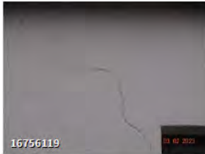
↳ 1e etage onder linkerraam lichte scheur (2 foto's)
