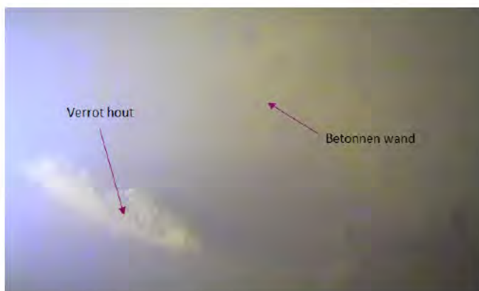
Figuur 16. Verrot hout en verticale betonnen wanddeel
