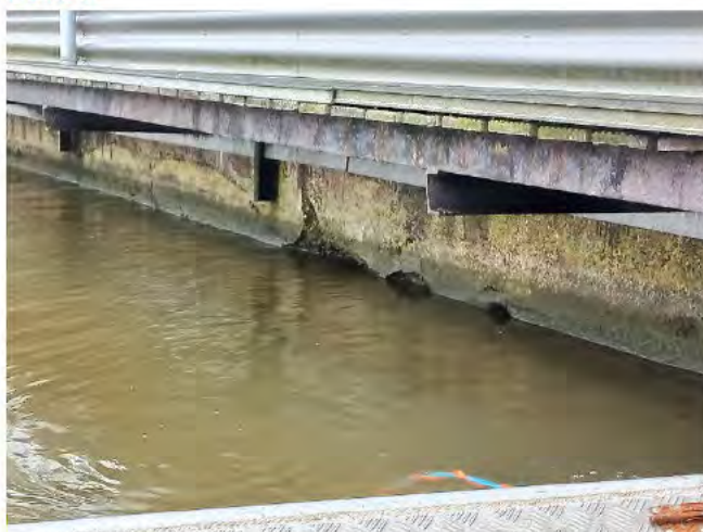
Figuur 49. Afbrokkelen beton
