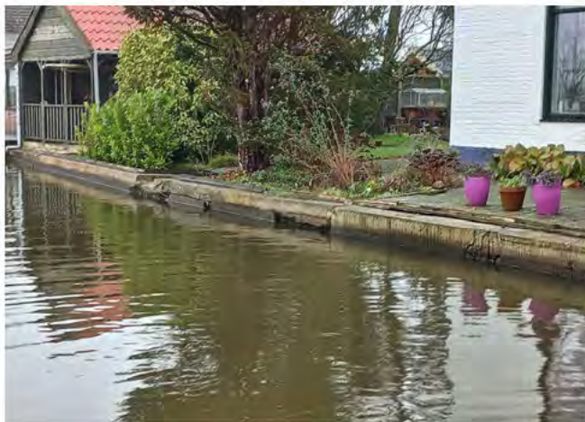
Figuur 60. Afbrokkelende betonconstructie op houten palen
