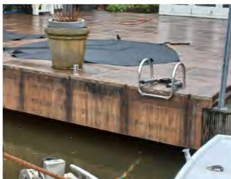
Figuur 42. Vlonder boven stalen damwand
