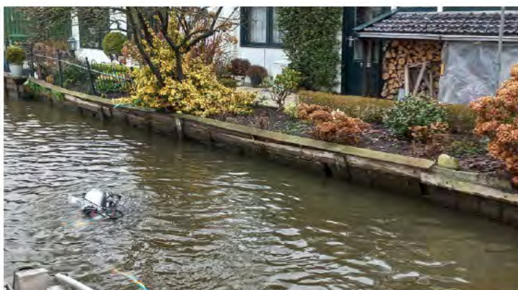
Figuur 80. Verzakte houten constructie
