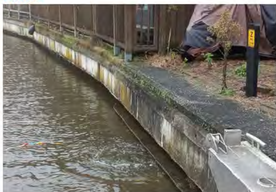
Figuur 11. Wrijfgording geen schades
