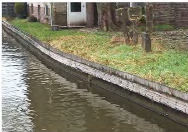
Figuur 64. Houten damwand
