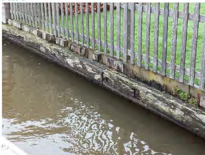
Figuur 32. Verrotte houten damwandplanken en aangetaste gording
