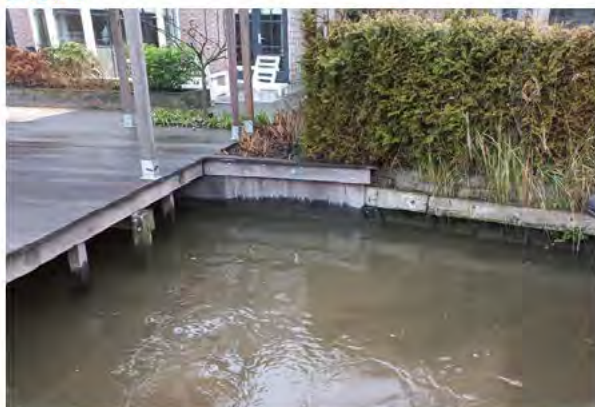
Figuur 36. Vlonder met houten damwand in goede staat
