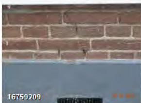
↳ Lichte scheur onder raam (1 foto)
