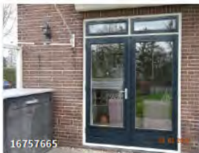
↳ Lichte scheur Dubbele deur links rollaag en linksboven (2 foto's)
