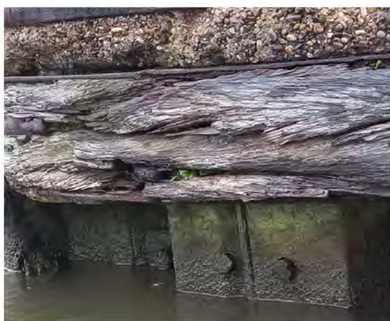
Figuur 6. Verrotte wrijfgording en gat in damwandplank rond waterlijn
