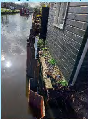
Voorbeeld damwand voor oude beschoeiing
