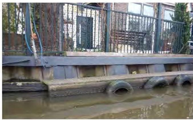
Figuur 71. Stalen damwand geplaatst onder helling
