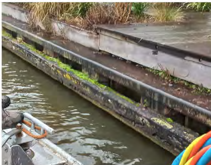
Figuur 28. Aanslag op houten gording
