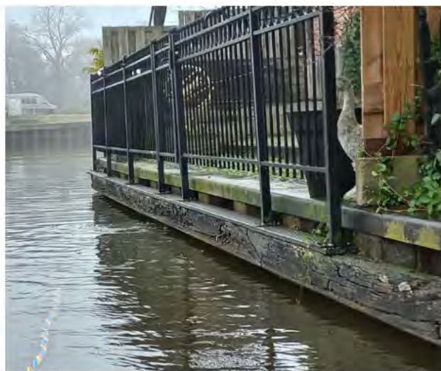
Figuur 27. Aangetaste gording
