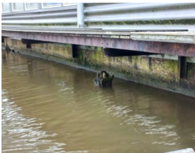
Figuur 7-4: Fundering onder garage, betonconstructie op houtenpalen (RoyalHaskoningDHV, 2022)
