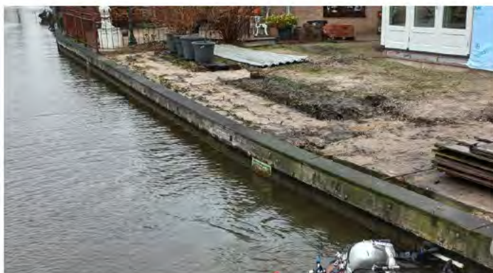
Figuur 55. Houten damwanden
