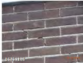
↳ Lichte scheur linksboven raam bg (2 foto's)
