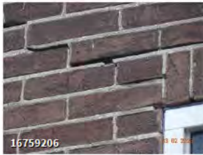
↳ Lichte scheur linksboven raam bg (2 foto's)
