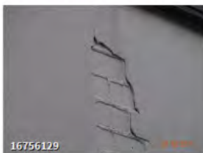
↳ Loskomend pleisterwerk 1e etage (4 foto's)
