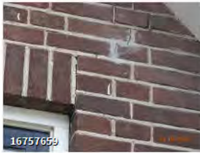
↳ Lichte scheur rechtsboven raam (2 foto's)
