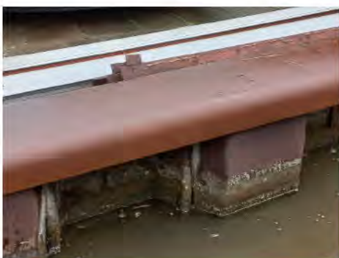
Figuur 44. Damwanden met stalen deksloof
