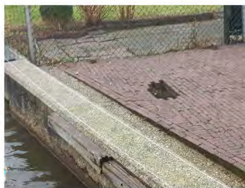
Figuur 19. Gronduitspoeling onder bestrating
