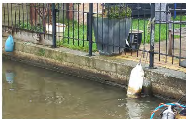
Figuur 54. Betonconstructie zonder onderliggende fundatie
