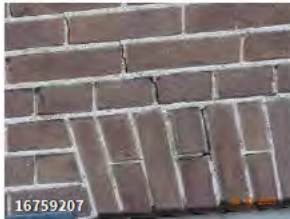
↳ Lichte scheur onder raam (1 foto)
