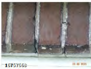
↳ Lichte scheur dubbele deuren rechts linksboven (1 foto)
