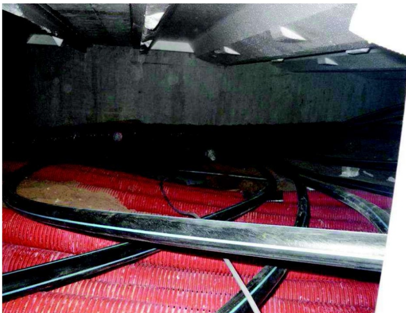
Figuur B3.11 aanleg in situ systeem in kruipruimte
