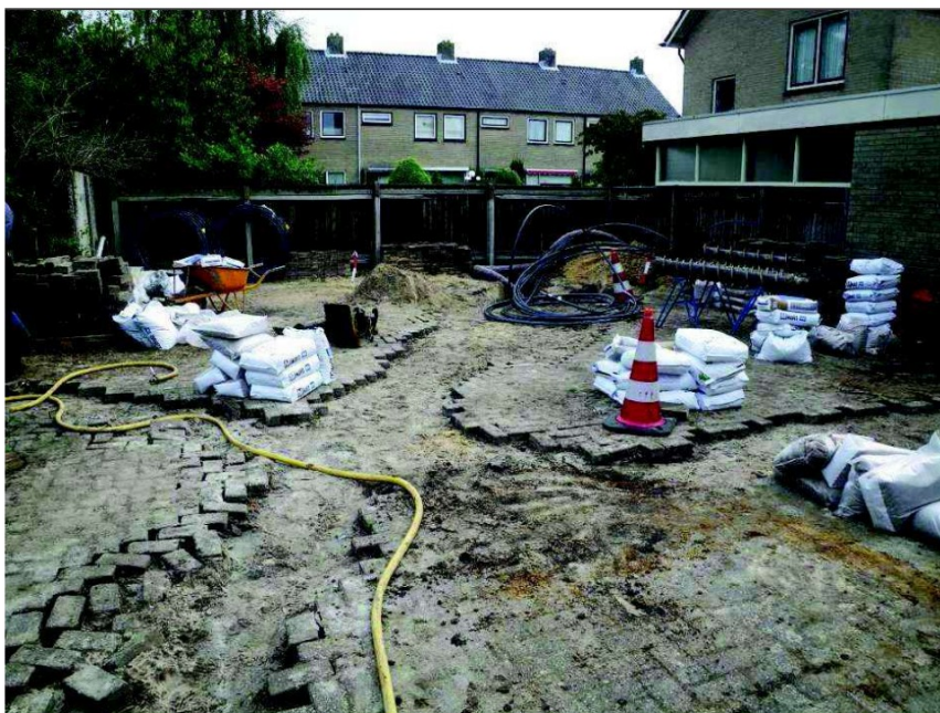
FiguurB3.1 Aanleg leidingen in bestrating
