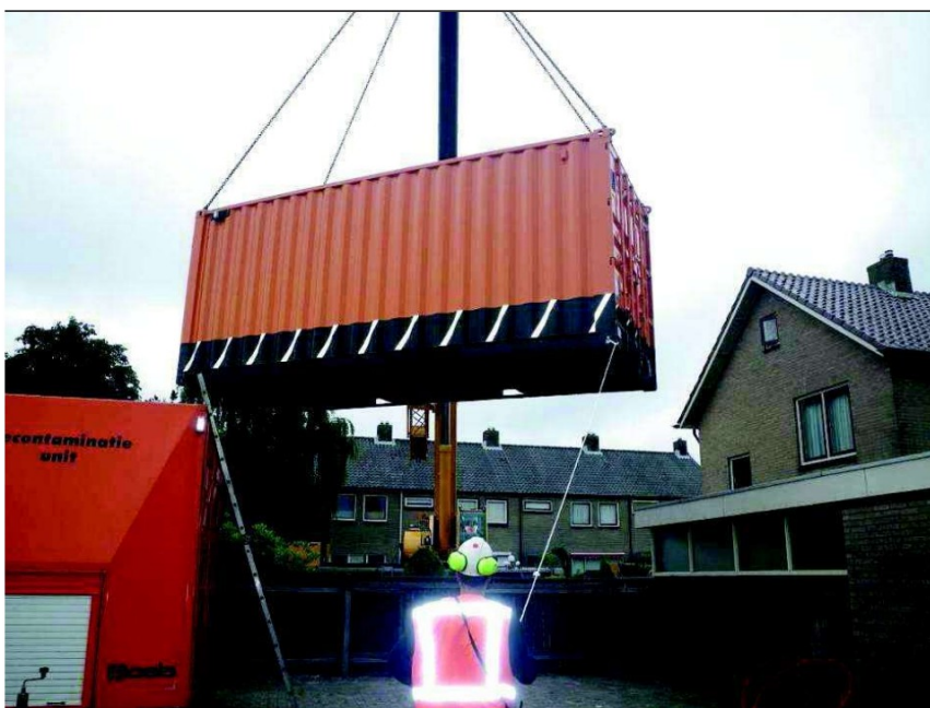
Figuur B3.12 Plaatsing aanstuurunit
