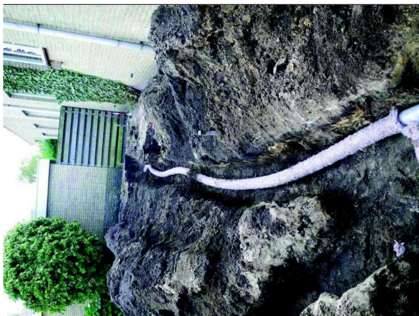
Figuur B3.4 Aanleg BLE drain
