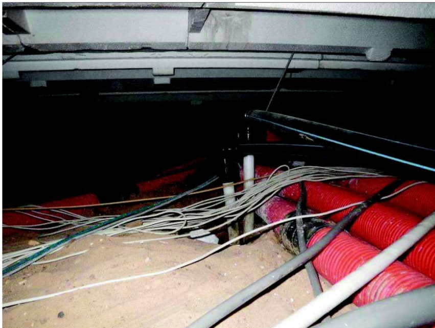
Figuur B3.10 aanleg in situ systeem in kruipruimte
