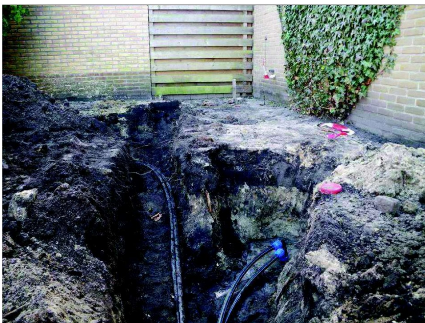
Figuur B3.2 aanleg leidingen aansluitingen op filters
