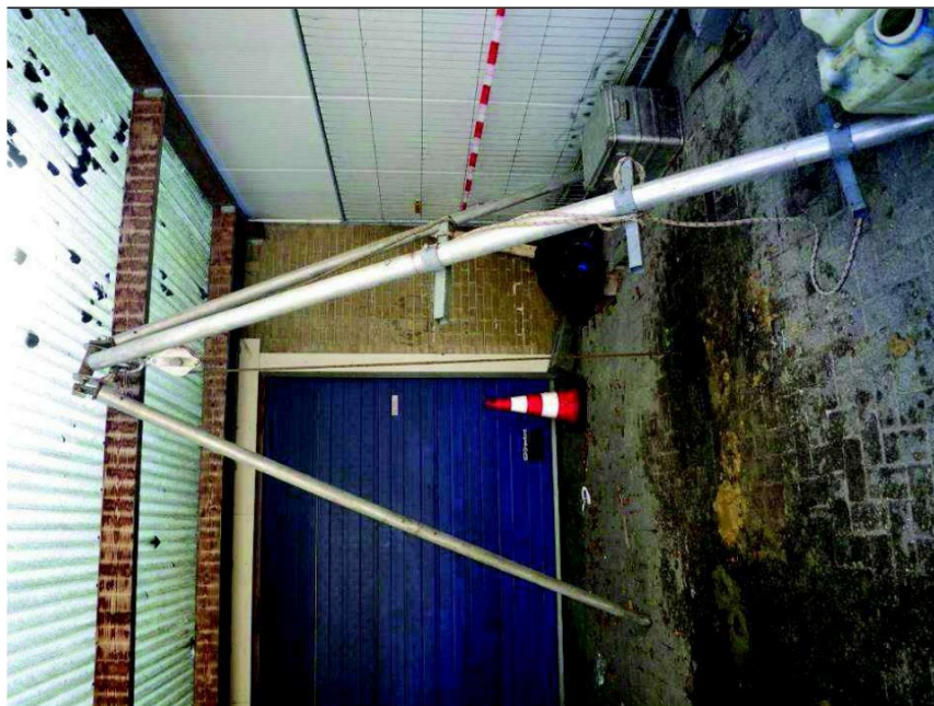
Figuur B3.3 Plaatsen filter onder afdak
