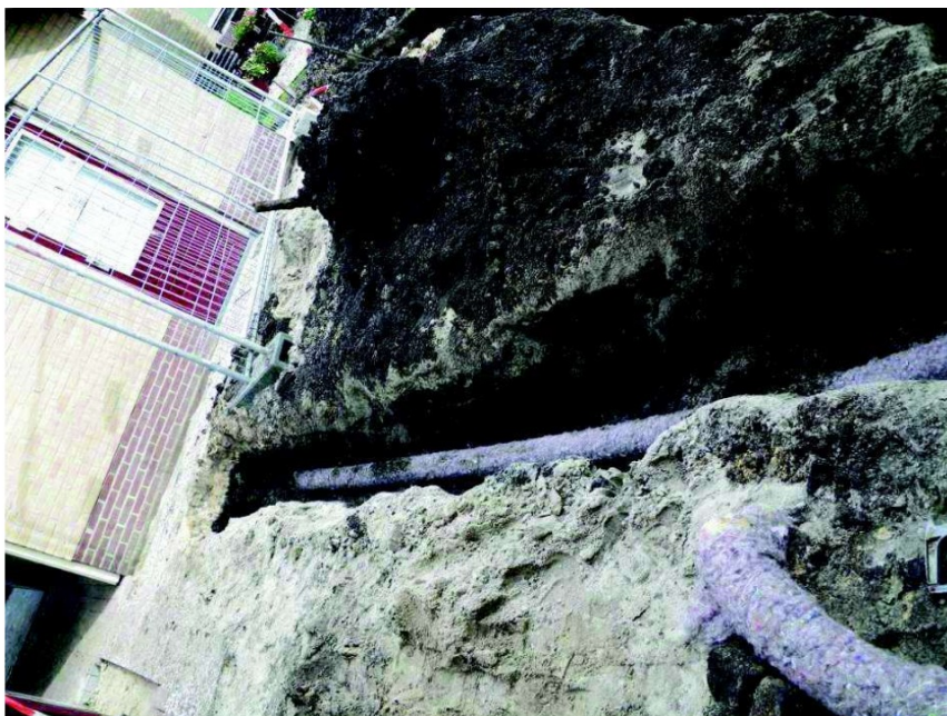
Figuur B3.7 Aanleg BLE-drain
