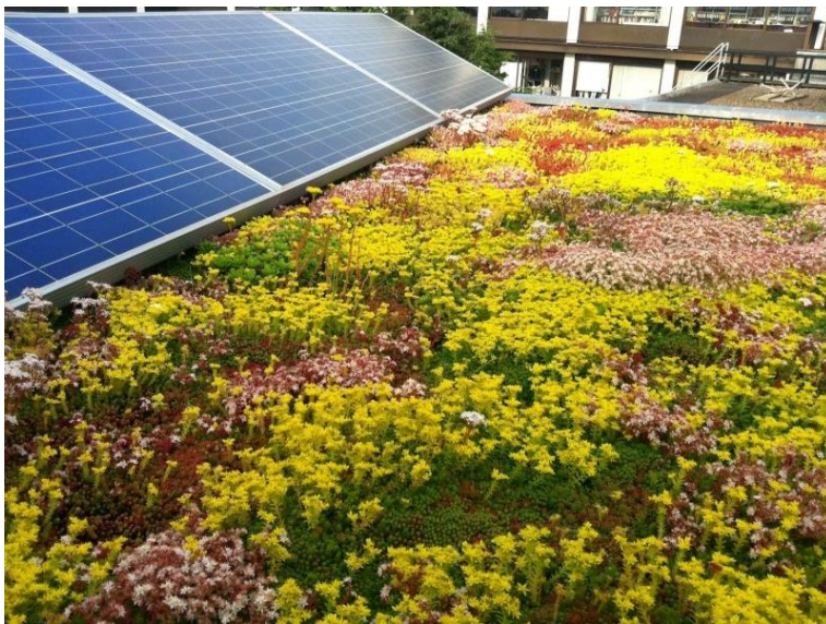
Afbeelding 9: Voorbeeld groendak/sedumdak met zonnepanelen
