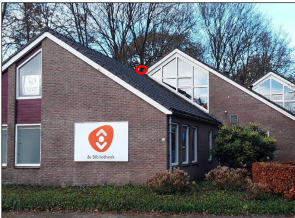
Figuur 2: Overzicht van toegang tot het steenmarterverblijf in het plangebied (bron: Activiteitenplan)
