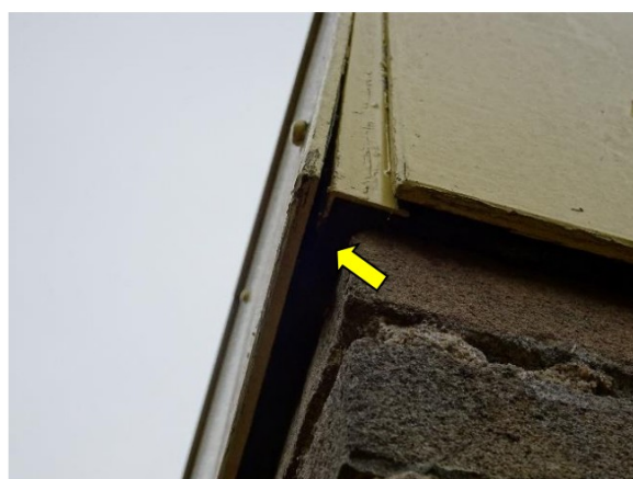
Figuur 5-5. Ruimte tussen gevel en betimmering.
