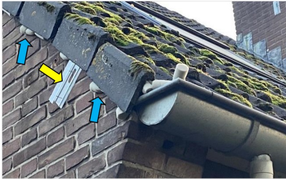
Figuur 3.4 Voorbeeld van geplaatste exclusion flap (gele pijl) aangevuld met rugvullingen (blauwe pijl), toegepast op opening richting ruimte onder het dak.
