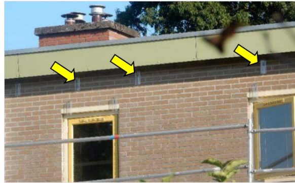
Figuur 3.5 Voorbeeld van geplaatste exclusion flaps toegepast op openingen richting de spouw.
