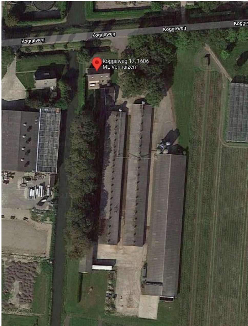
Afbeelding 1: luchtfoto projectlocatie Koggeweg 17 te Venhuizen (bron: Cyclomedia)
