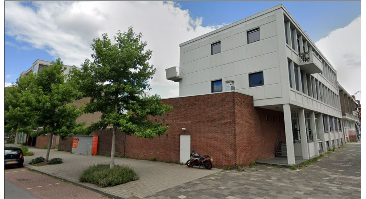
Foto 2 bestaande hoek aanzicht
