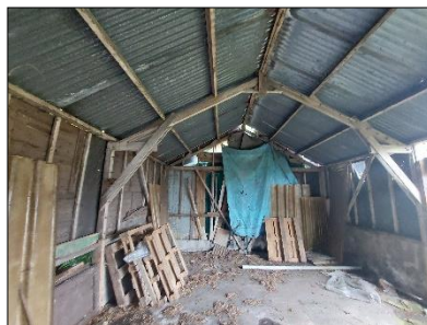
Figuur 2.7 (D) Binnenkant opstal, waarbij het houten frame zichtbaar is.
