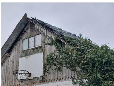
Figuur 5.1 Dakrand opstal I met vele gaten en spleten voor toegang tot mogelijke verblijfplaatsen vleermuizen.
