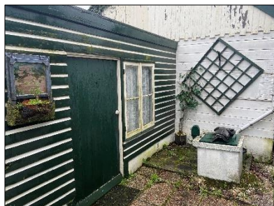
Figuur 2.13 (J) Buitenkant opstal.
