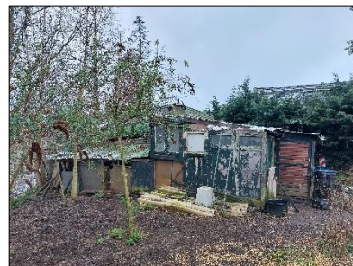
Figuur 2.14 (K) Buitenkant opstal bestaande uit verschillende materialen.
