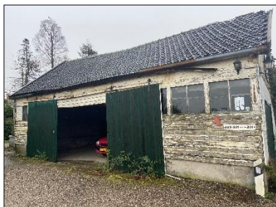
Figuur 2.12 (I) Opstal met houten beschot en dakpannen dak.
