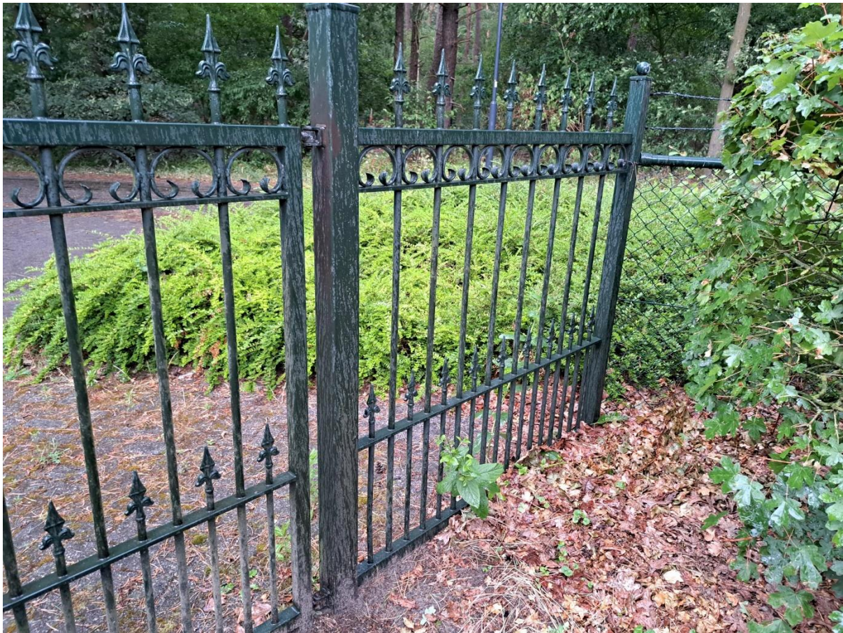
Ander hekwerk bij de poort aan de voorkant van het terrein
