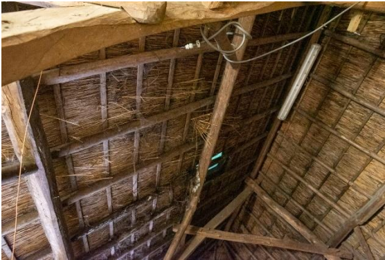
Foto 1: dakconstructie van de binnenkant van de schuur.
