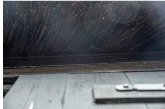
Foto 5: onderaanzicht dakrand. Geen kiervorming te zien.
