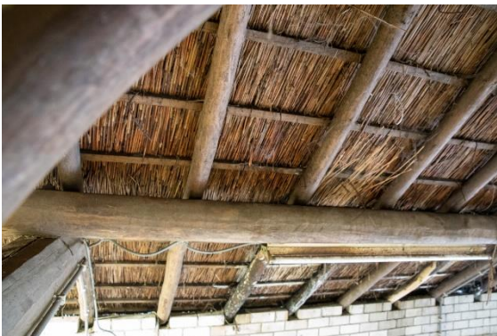
Foto 11: dakconstructie van de binnenkant van de schuur.
