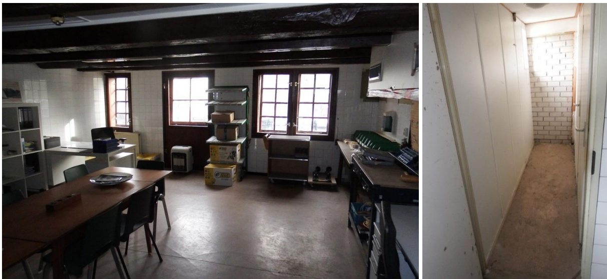
Afb. 21: Links de inrichting van de kantine naar de voorgevel; de linkerhelft van het 2-licht venster bevindt zich op de overloop achter de wand links. Rechts de gang met de dicht gemetselde opening naar huisnummer 56; de achtergevel bevindt zich links.
