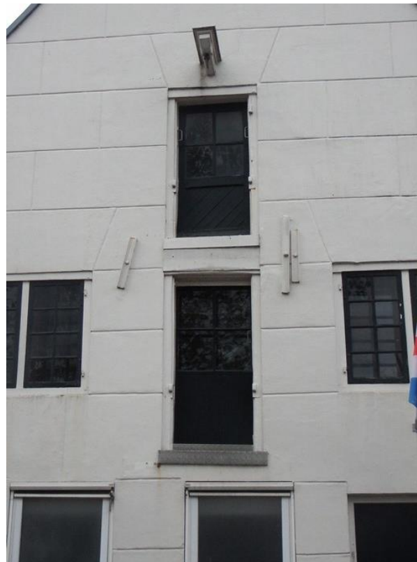
Afb. 26: Voorgevel van huisnummer 57 met de 4-ruits deuren. In de borstwering van de bovenste is een diagonale beplanking aangebracht.
