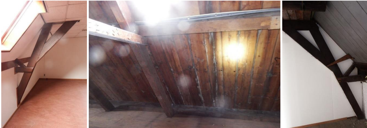
Afb. 41: Huisnummer 57. Links en rechts stijlen van jukken met blokkeels en drukschoren. In het midden een A-spant op de vloering en aan de rechter rand de afdruk van de oplegging op het oorspronkelijke spantbeen
