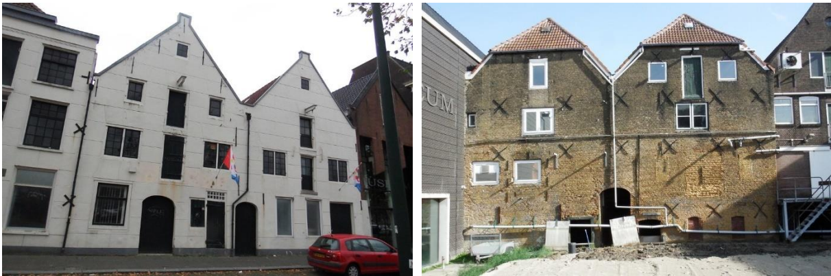
Afb. 23: overzicht van de gevels. Links de gepleisterde voorgevel met blokkenverband aan de Westhavenkade en rechts de gemetselde achtergevel.
