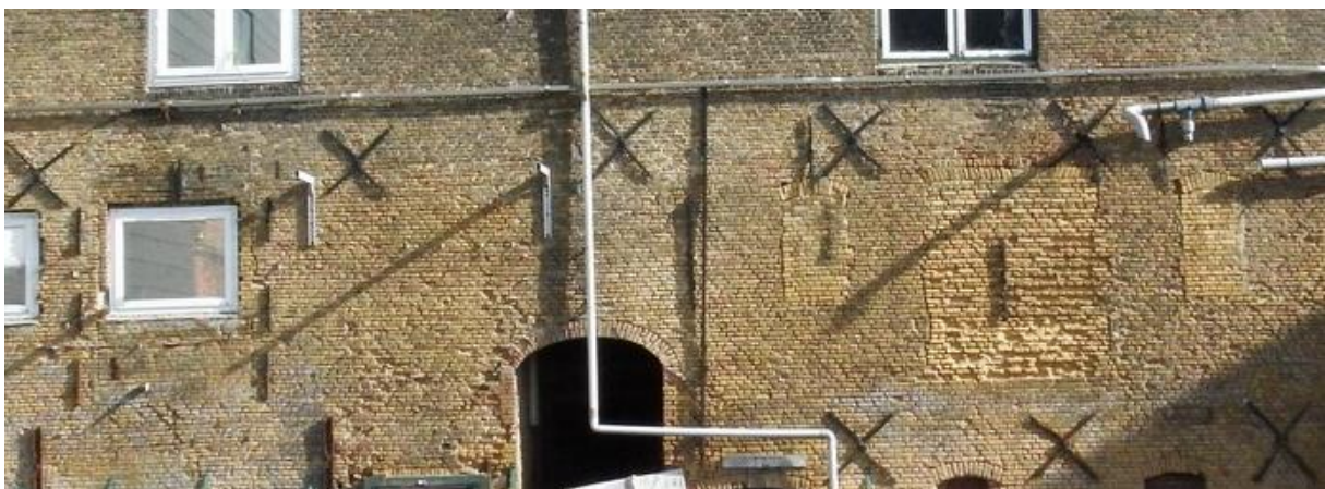
Afb. 17: Gedeelte van de achtergevel op de eerste bouwlaag met de dichtgemetselde centrale openingen.
