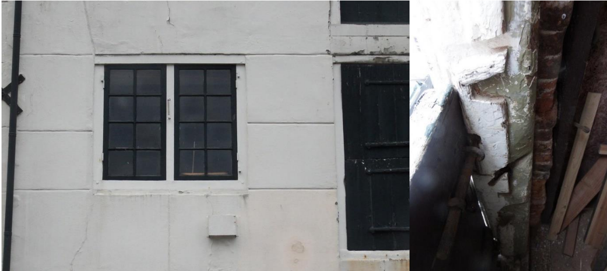
Afb. 25: Een 2-licht venster (bolkozijn) en daarnaast de deur in twee leden in de gevel van huisnummer 58 (links). Daarnaast de rechter stijl van de deur in twee leden met diverse inkepingen.
