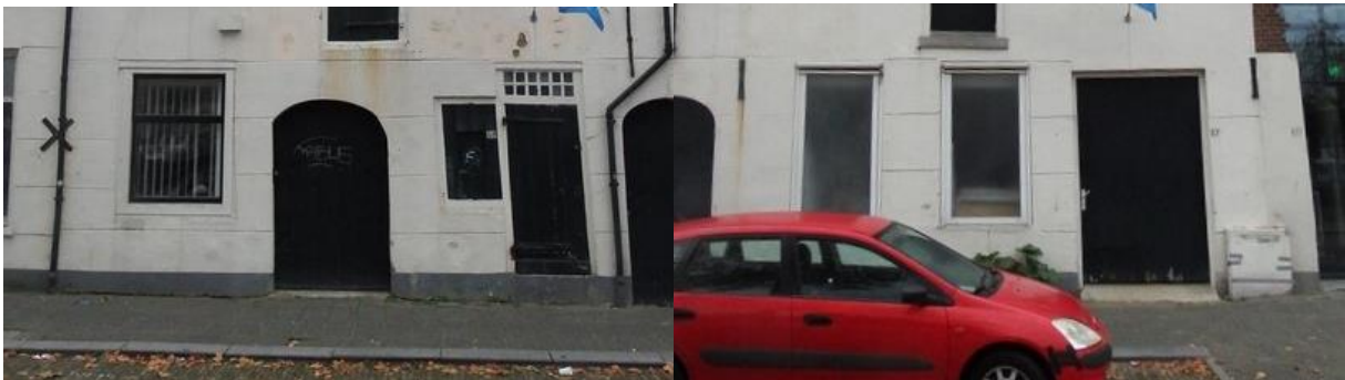
Afb. 27: Openingen op de eerste bouwlaagerste bouwlaag
