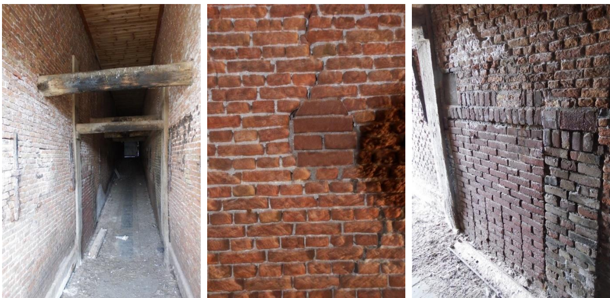
Afb. 32: Verbindingsgang. Links een overzicht naar de Westhavenkade, in het midden een met grote bakstenen dichtgezette balkoplegging en rechts de dichtzetting van een opening naar het souterrain van huisnummer 57.
