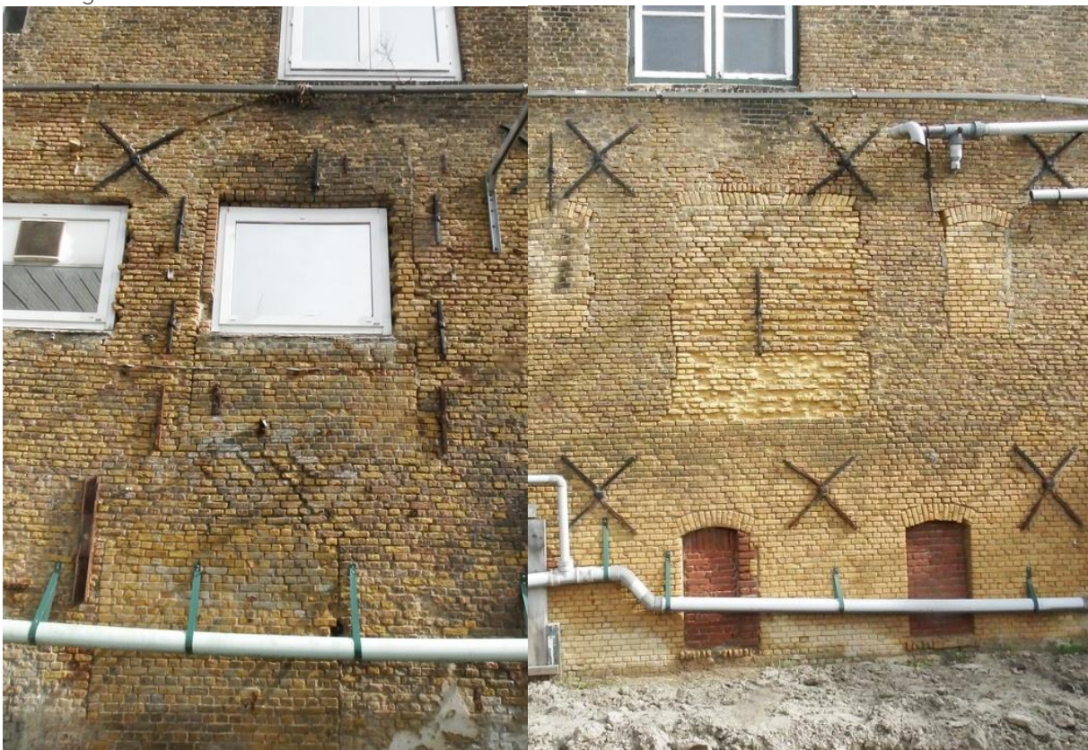
Afb. 29: Details van de achtergevel op de eerste bouwlaag. Links het gevelgedeelte in huisnummer 57 met de dichtgezette en gedeeltelijk opnieuw geopende opening omzoomd door ankers met rechte schieter. Rechts het gevelgedeelte in huisnummer 58 met de dichtgezette centrale opening en de uitgehakte en dichtgezette flankerende openingen.
