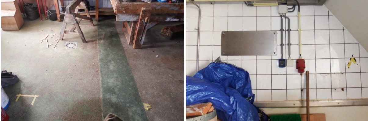
Afb. 22: Naden in de afwerking van de eerste bouwlaag. Links de aanheling van de vloeistofdichte vloer en rechts de wandtegels met twee verschillende kleuren voegwerk.
