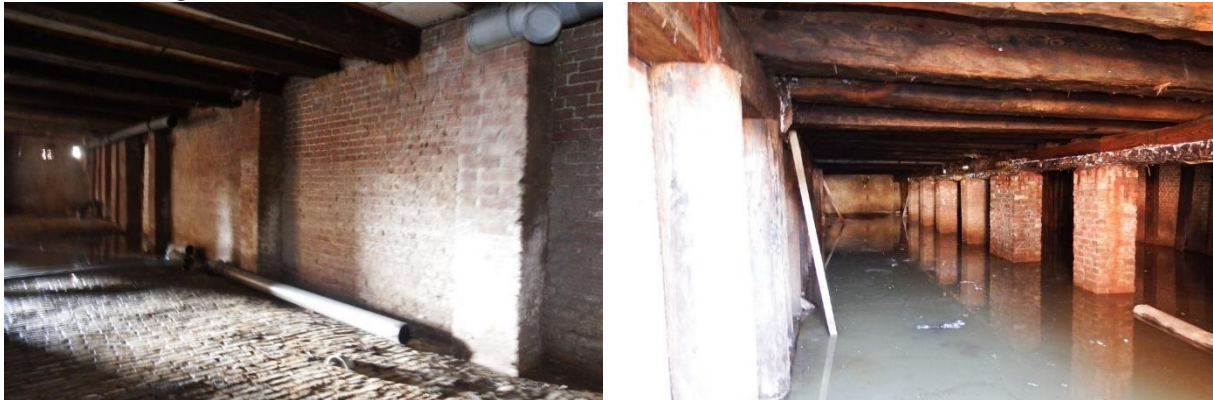
Afb. 31: Overzicht van de souterrains. Links langs de rechter zijwand van huisnummer 57 en rechts naar de voorwand van huisnummer 58.
