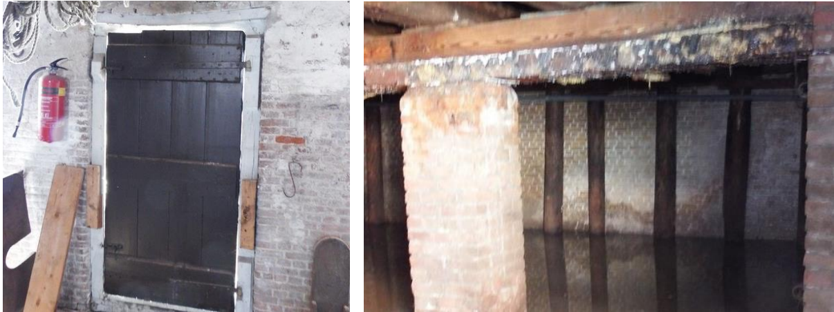
Afb. 15: Links de binnenzijde van de voorgevel van huisnummer 58, waarvan het onderste gedeelte is uitgevoerd als schoonwerk en overgaat in vertinwerk/pleisterwerk. Rechts de linker zijwand in het souterrain van huisnummer 58 met de wandkolommen en de slof, waarop de balklaag ligt.
