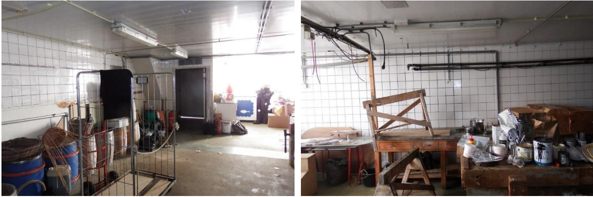
Afb. 34: Huisnummer 57. Links een overzicht van de ruimte gezien naar de voorgevel met links de achterzijde van de trap naar de volgende bouwlaag. Rechts het tegelwerk van de linker zijwand met twee verschillende voegkleuren.
