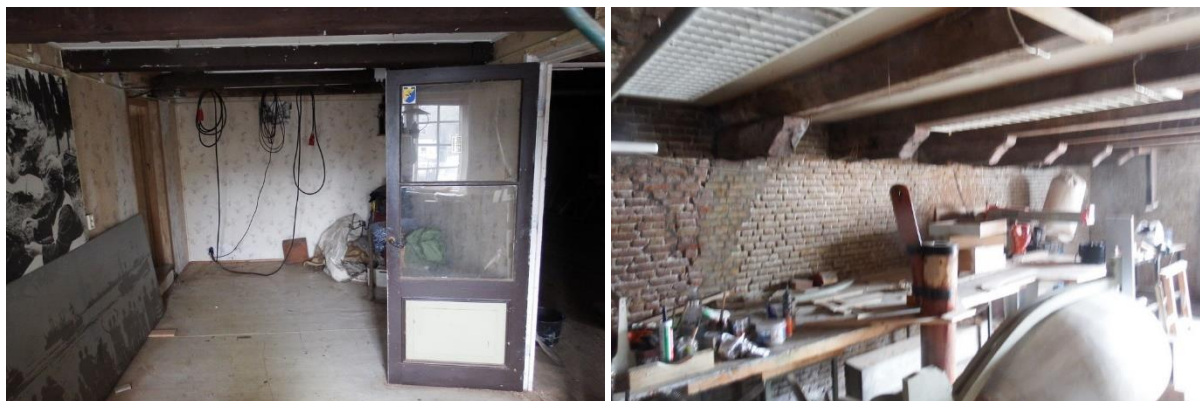
Afb. 39: Huisnummer 58. Links de ingebouwde ruimte (pantry) met doorgang naar huisnummer 59 (links). Rechts een overzicht van de ruimte langs de linker zijwand.
