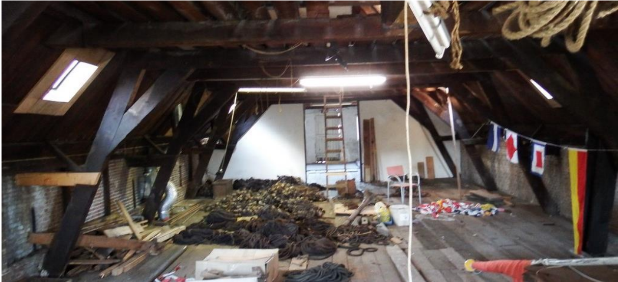
Afb. 42: Zolderruimte van huisnummer 58 gezien naar de achtergevel.
