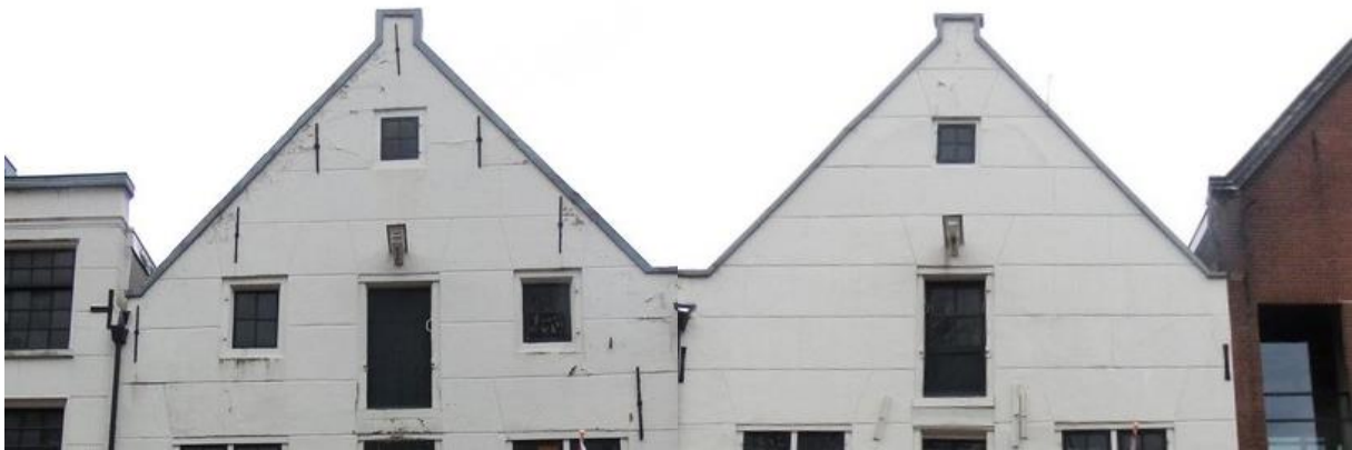
Afb. 18: Topgevel van huisnummer 58 (links) met zichtbare ankers langs de rand en twee vensters op zolderniveau. Daarnaast de vereenvoudigde topgevel van huisnummer 57 zonder deze extra kenmerken
