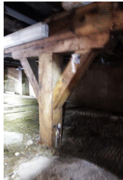
Afb. 30:: Standvink met slof en schoren onder de onderslag in huisnummer 57.
