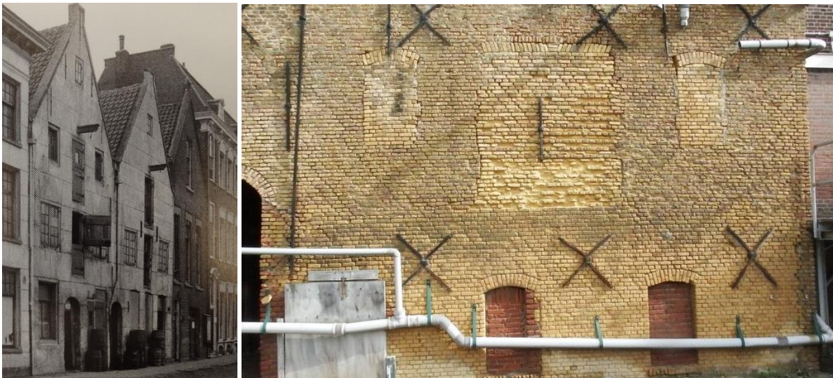
Afb. 3: Links voorgevels aan de Westhavenkade rond 1910 met T-ruits schuifvenster. Rechts de achtergevel met de aan de bovenzijde getoogde openingen die op de eerste bouwlaag zijn dichtgezet en ter plaatse van het souterrain in het ingeboete gevelgedeelte zijn aangebracht.
