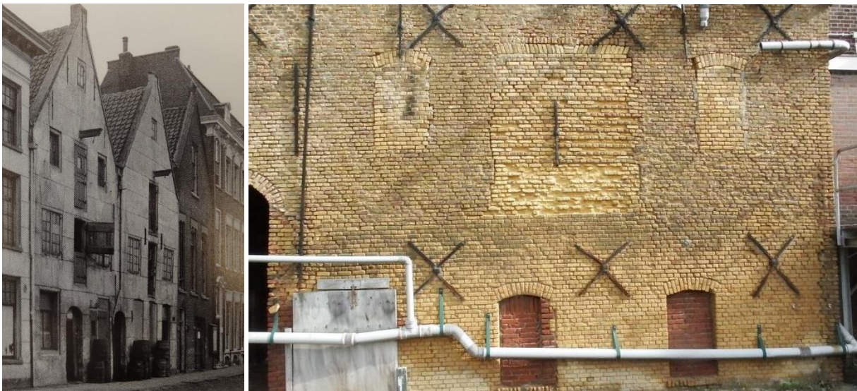
Afb. 20: Links voorgevels aan de Westhavenkade rond 1910 met T-ruits schuifvenster. Rechts de achtergevel met de aan de bovenzijde getoogde openingen die op de eerste bouwlaag zijn dichtgezet en ter plaatse van het souterrain in het ingeboete gevelgedeelte zijn aangebracht.
