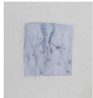
Afb.41-42. Verdieping, gang, details. Op een enkele plek is ter hoogte van de deurklink in de muur een marmeren plaatje bevestigd om beschadigingen te voorkomen.
