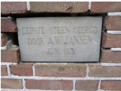
Eerste steen in de schuur. Gelet op (het ontbreken van) de voegen, lijkt het er op alsof de steen een keer is verplaatst.
