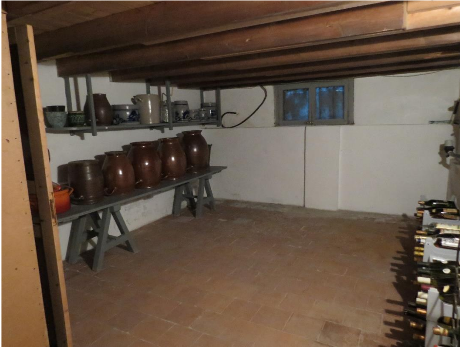
Afb.35. Kelder, met balkenplafond, estrikken en keldervenster.
