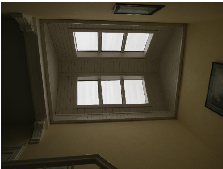
Afb.38. Boven de trap, net onder de nok van het achterhuis, zijn dakvensters aangebracht.
