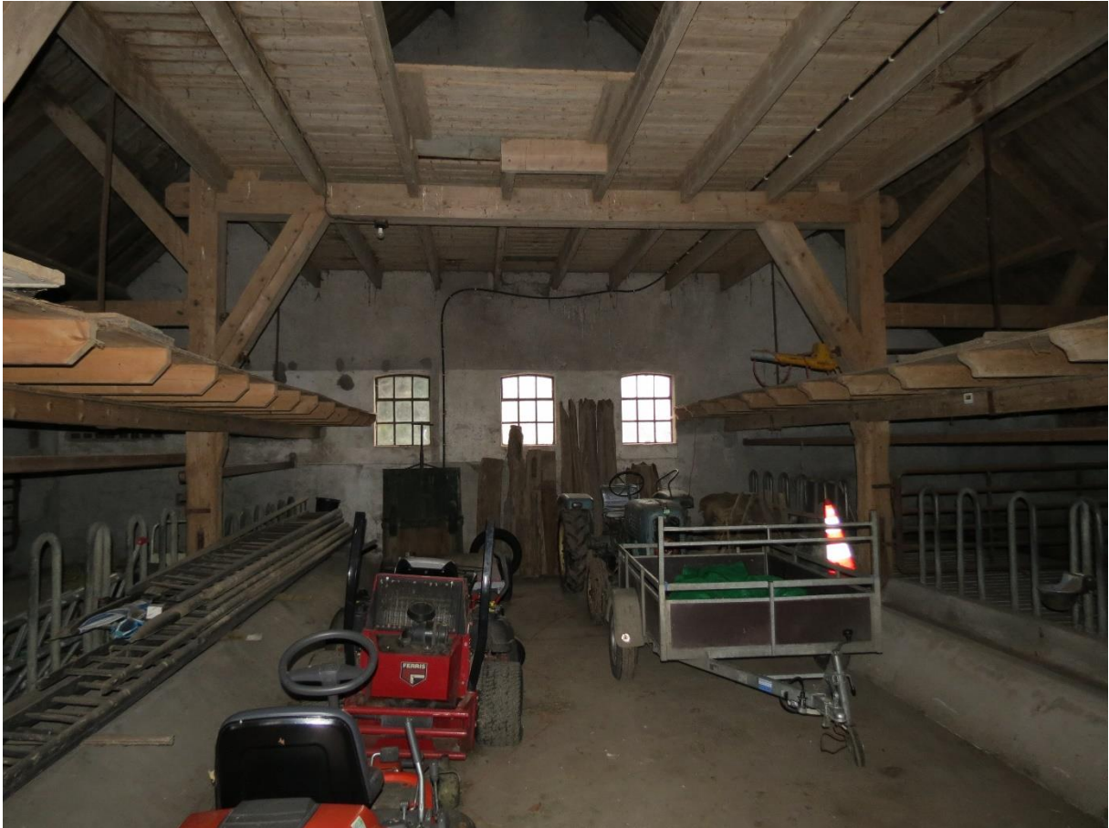
Afb.60. Schuur, interieur met kapconstructie, hildes en houten vloer.
