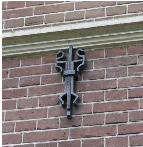
Afb.13. Rechterzijgevel, muuranker.
