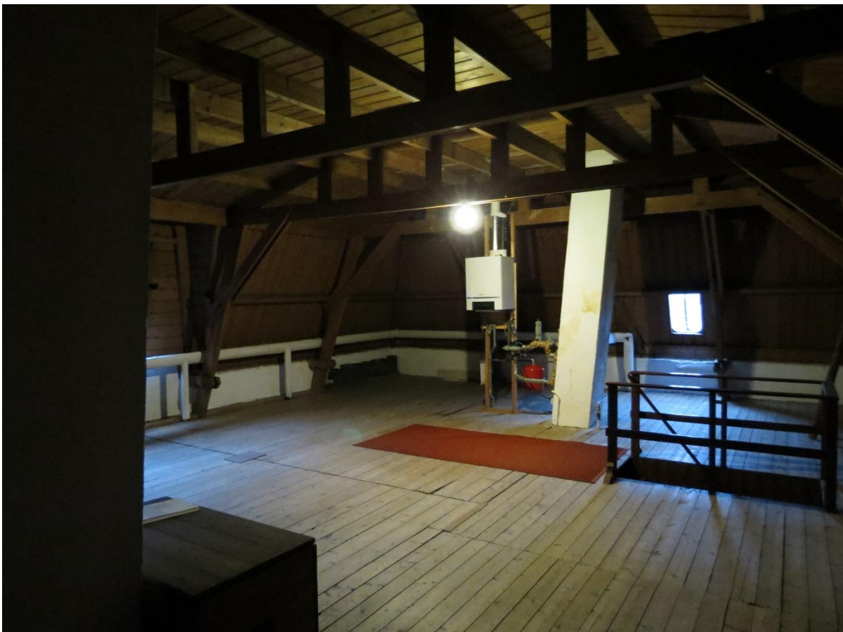
Afb.50. Zolder, met houten vloer, kapgebinten en dakbeschot.
