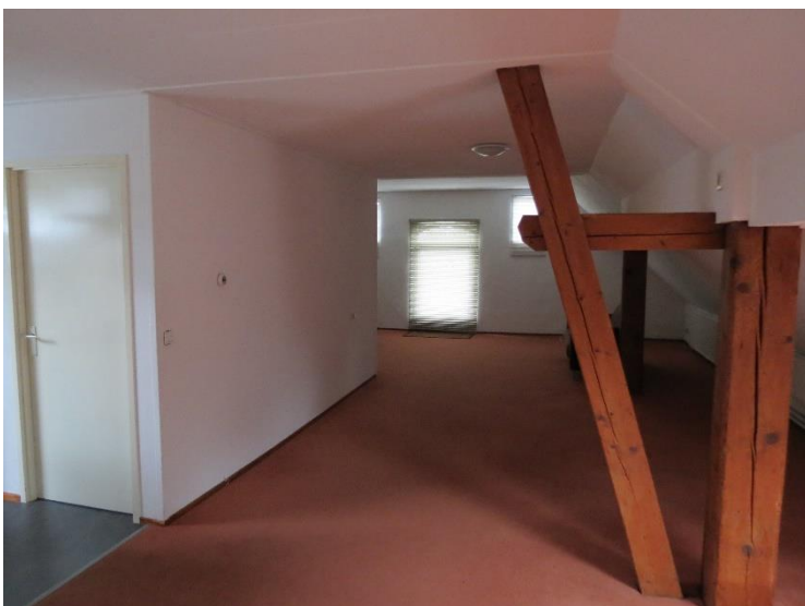
Afb.56. Achterhuis, zolderverdieping met gebintconstructie.
