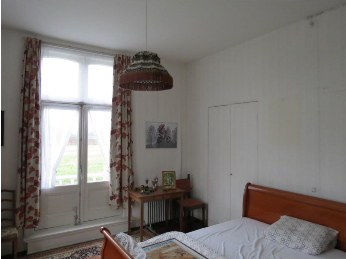
Afb.43. Verdieping, kamer linksvoor. De paneeldeuren van de inloopkasten zijn met plaatmateriaal afgewerkt.
