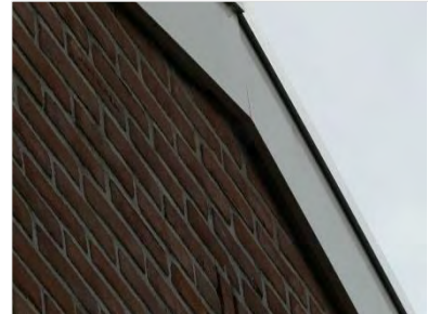
Figuur 7.3 Ruimte achter betimmering.
