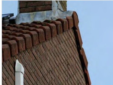
Figuur 7.2 Overhangende kantpannen met voldoende ruimte.
